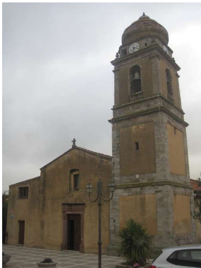
Figura 198: Chiesa Parrocchiale Sant'Andrea (complesso) (id bene: 2997874), bene architettonico di interesse
