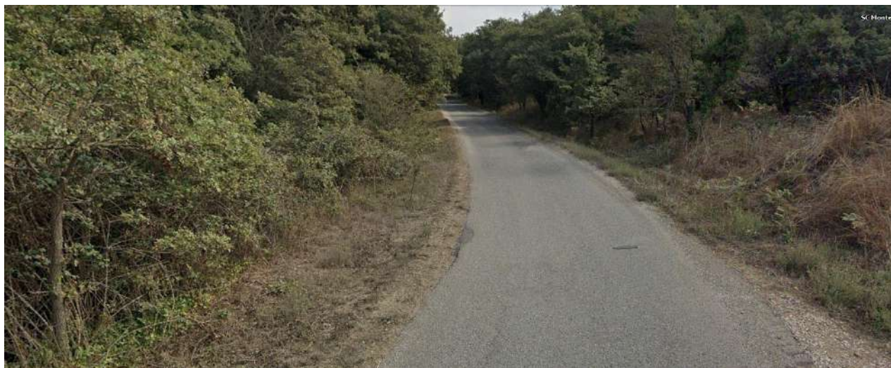
Figura 33 - Strada sulla quale verrà realizzato il Cavidotto AT 36 kV (Terzo inquadramento)
