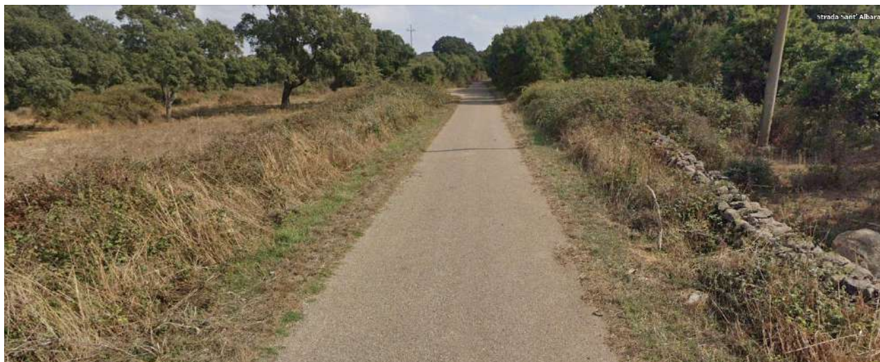
Figura 31 - Strada sulla quale verrà realizzato il Cavidotto AT 36 kV (Secondo inquadramento)
