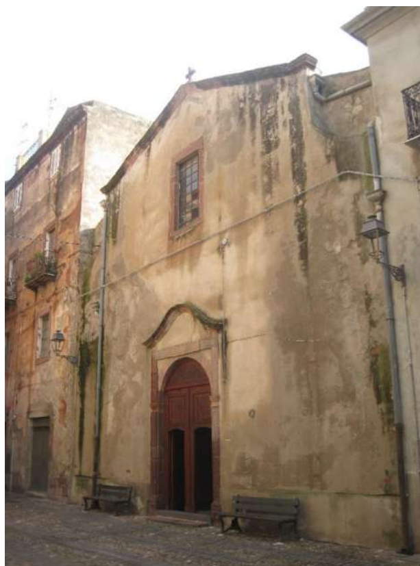
Figura 190: Chiesa di Santa Croce (id bene: 2998364), bene architettonico di interesse culturale dichiarato, Comune di Bosa.
