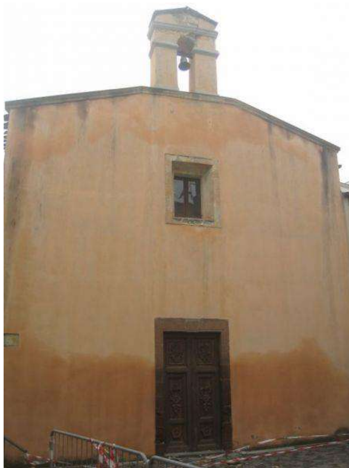
Figura 195: Chiesa della Beata Vergine del Carmelo (id bene: 3131396), bene architettonico di interesse culturale dichiarato, Comune di Cuglieri.
