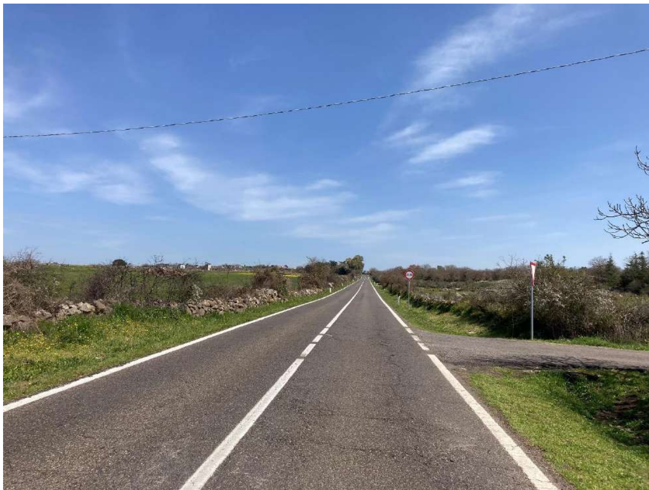
Figura 83: Cono fotografico P7: vista della strada su cui è previsto l'adeguamento stradale per l'area di manovra e di quella dove è prevista la realizzazione del cavidotto AT 36 kV.
