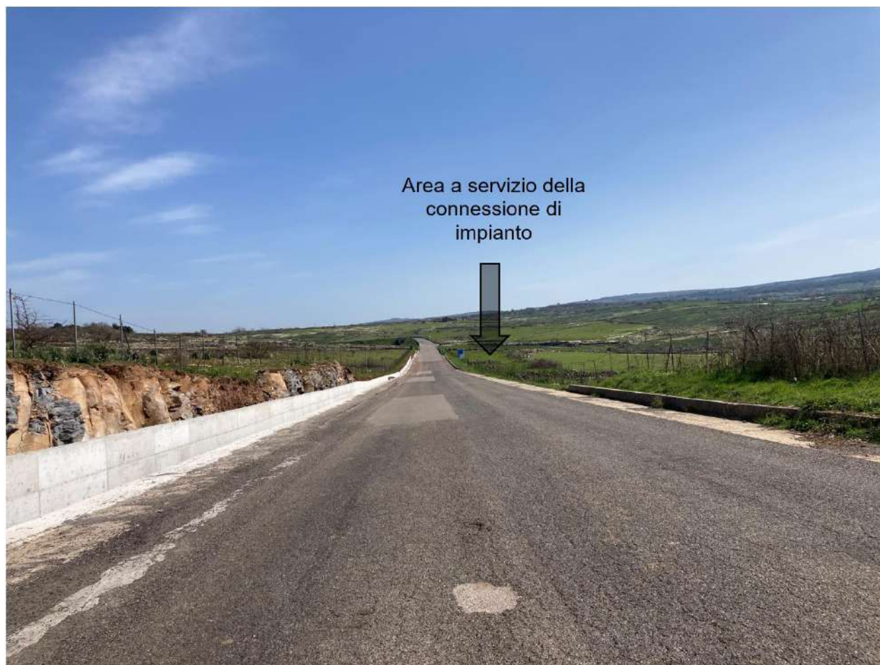
Figura 85: Cono fotografico P9: vista della strada su cui è prevista la realizzazione del cavidotto AT 36 kV e dell'area a servizio della connessione di impianto.
