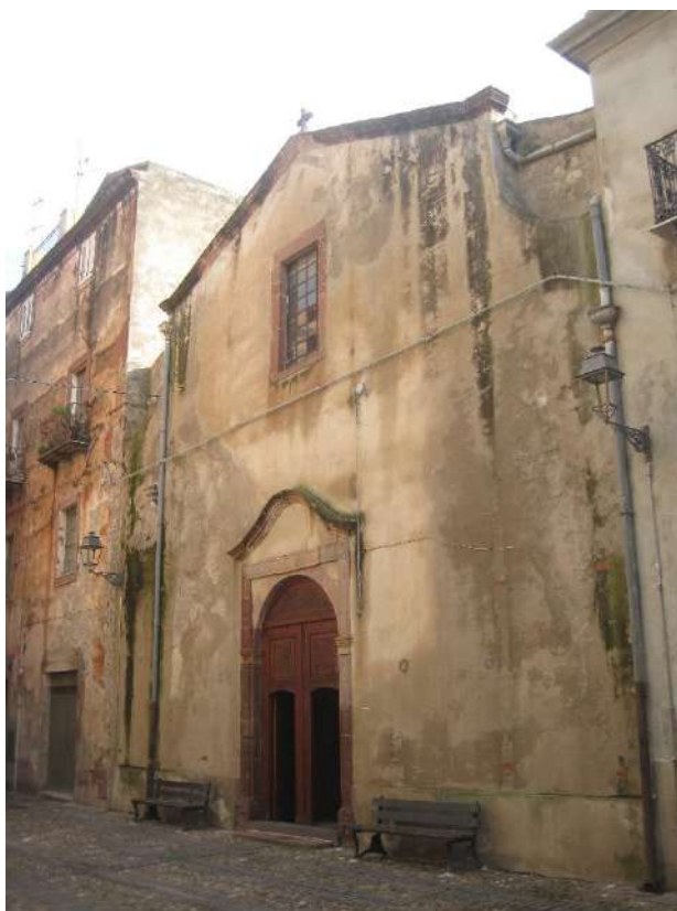
Figura 99: Chiesa di Santa Croce (id bene: 2998364), bene architettonico di interesse culturale dichiarato, Comune di Bosa.
