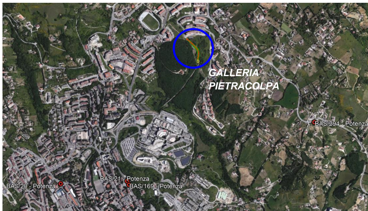
Figura 10 – Ubicazione dei siti contaminati rispetto alla Galleria Pietracolpa indicata con il cerchio blu
