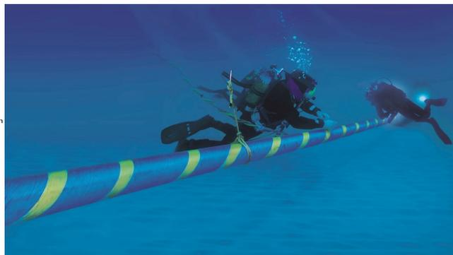
Figg. 15a, 15b - Sezione del cavidotto marino di collegamento al collettore e posa sul fondale.
