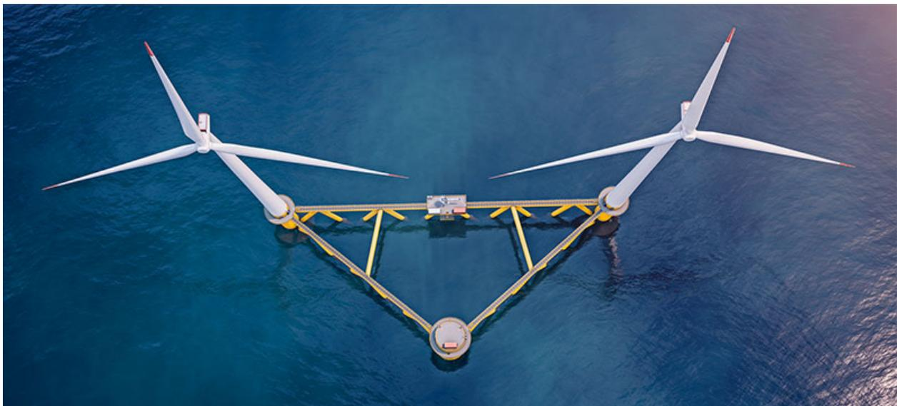
**Figure 8/9 – Struttura di fondazione galleggiante con doppio aerogeneratore**
