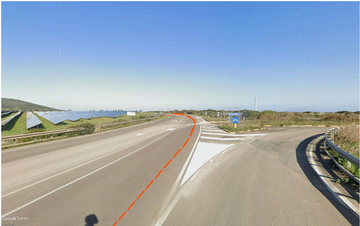
Vista 24: Svincolo a raso sulla S.P. 42 con accesso lato ovest alla zona industriale di Porto Torres.
