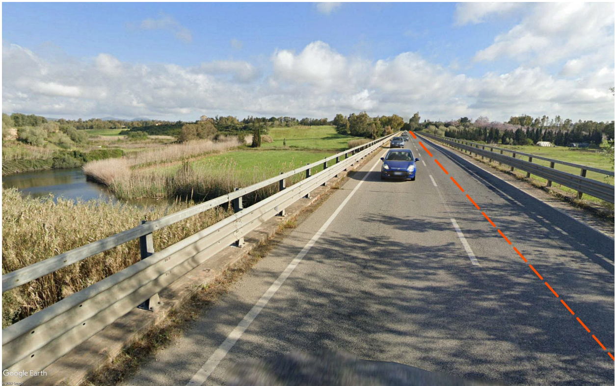
Vista 13: S.P. 42 in corrispondenza del viadotto sul Rio Barca.
