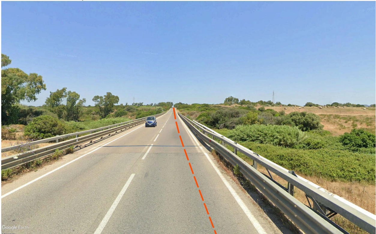
Vista 14: S.P. 42 in corrispondenza del viadotto sul Riu Sassu.
