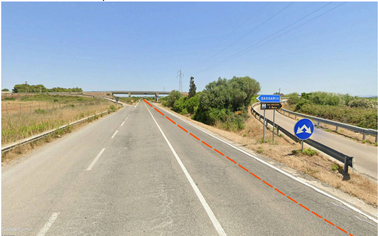
Vista 16: Svincolo sulla S.P. 42 in corrispondenza della Zona Industriale San Marco.
