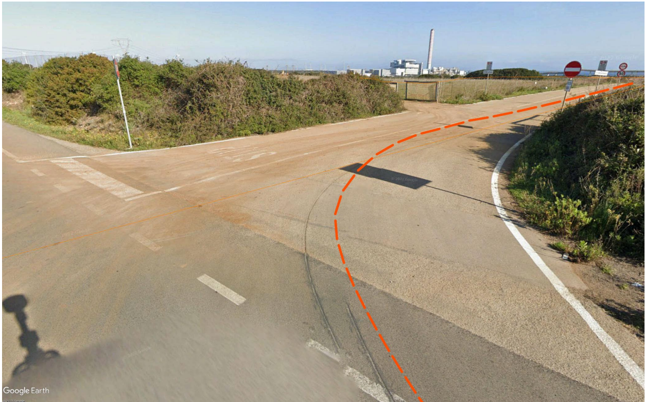
Vista 25: Uscita a raso sulla S.P. 57 con accesso a strada chiusa al traffico, che porta alla Centrale di Fiume Santo.
