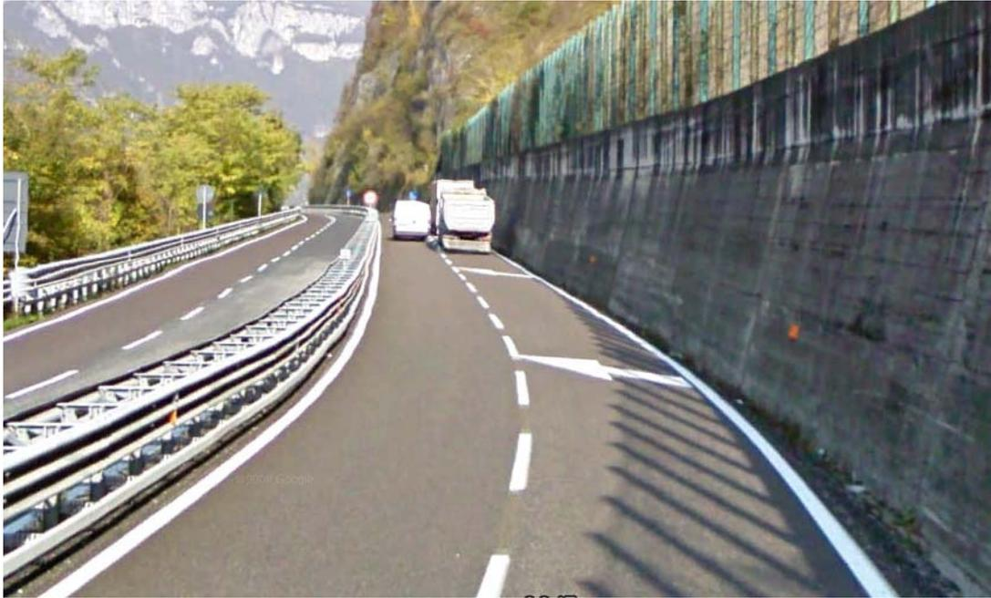
Le caratteristiche della piattaforma stradale esistente sono variabili. Si passa, infatti, da una sezione a carreggiate separate da spartitraffico centrale con due corsie per senso di marcia e prive di margini laterali ad una sezione che ha una sola corsia di marcia in direzione Trento, come si evince dall'immagine seguente:
