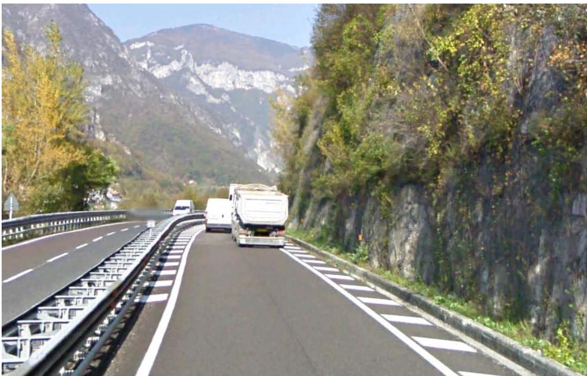
L'ingresso all'abitato di Rivalta, provenendo da Bassano, è ubicato subito dopo una curva e con ridotta visibilità e poco spazio disponibile per effettuare le manovre di decelerazione e cambio di corsia per l'uscita.
