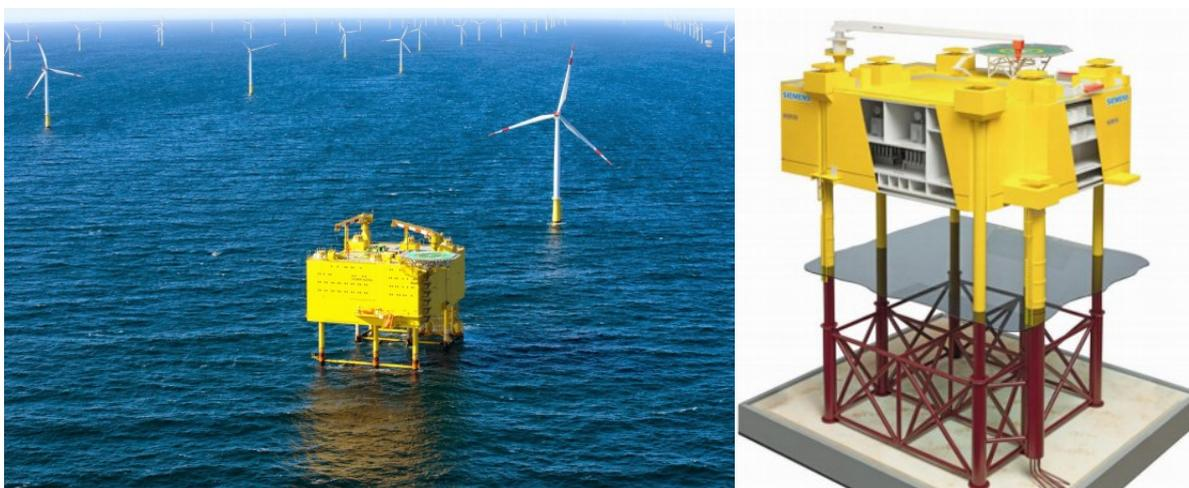
Figura 22 – Stazione HVAC di trasformazione 66/380 kV.
