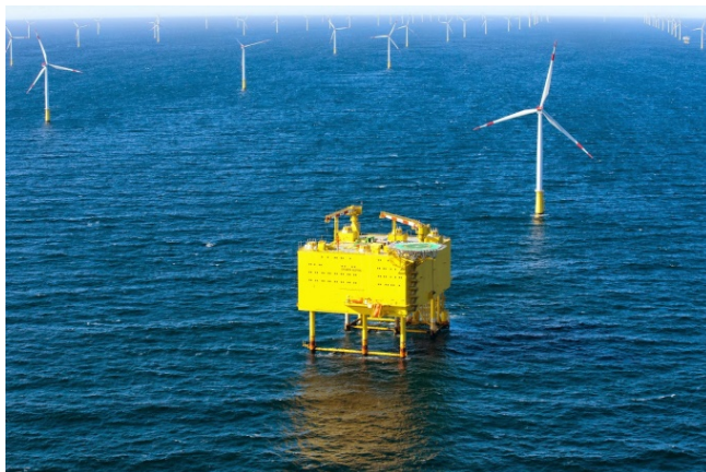
Figg. 10, 11 - Sottostazione elettrica offshore HVAC.
