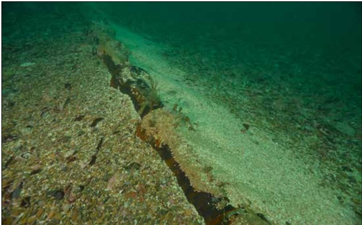
Figura 12 - esempio di accumulo di detrito sul cavidotto (da Normandeau et al., 2011)
