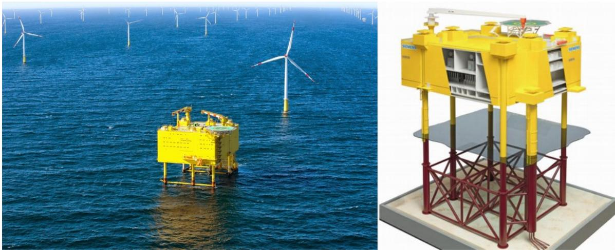
**Figura 8 – Stazione HVAC di trasformazione e conversione 66/380 kV**
