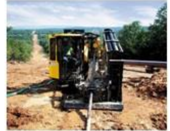
PERFORAZIONI MEDIANTE LA NO-DIG
