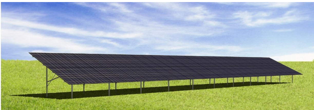
Immagine 4.2 tipologia di struttura di sostegno moduli fissa
