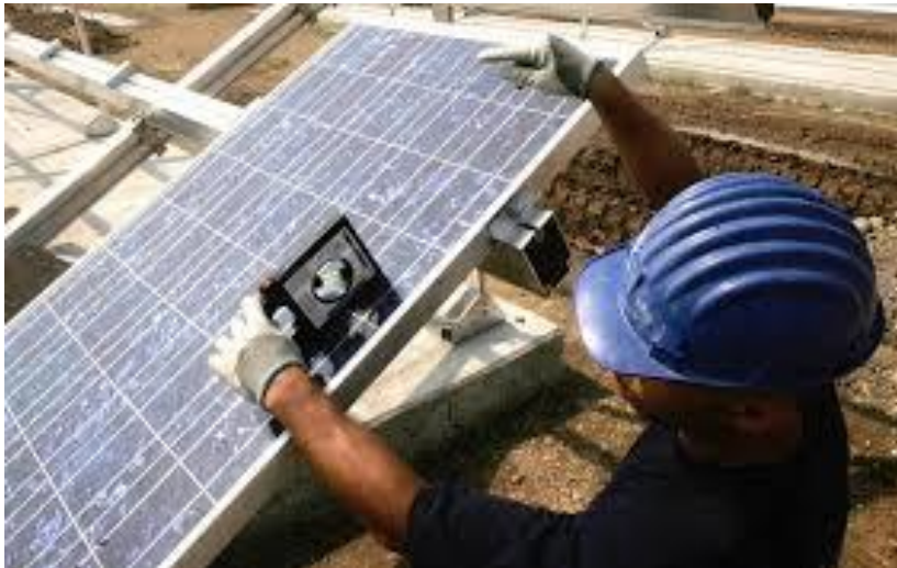
Figura 8. Operai montatori di pannelli fotovoltaici su suolo
