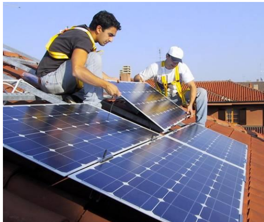
Figura 7. Operai montatori di pannelli fotovoltaici su solai di copertura
