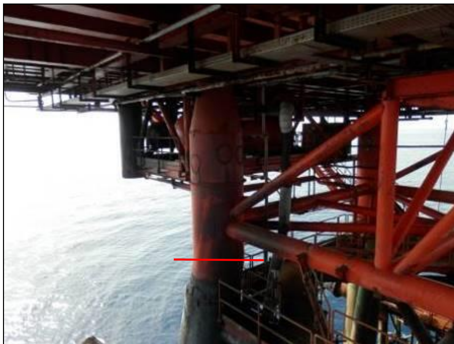
Figura 4.7 - Sezione Taglio Deck e Modulo Testa Pozzo
