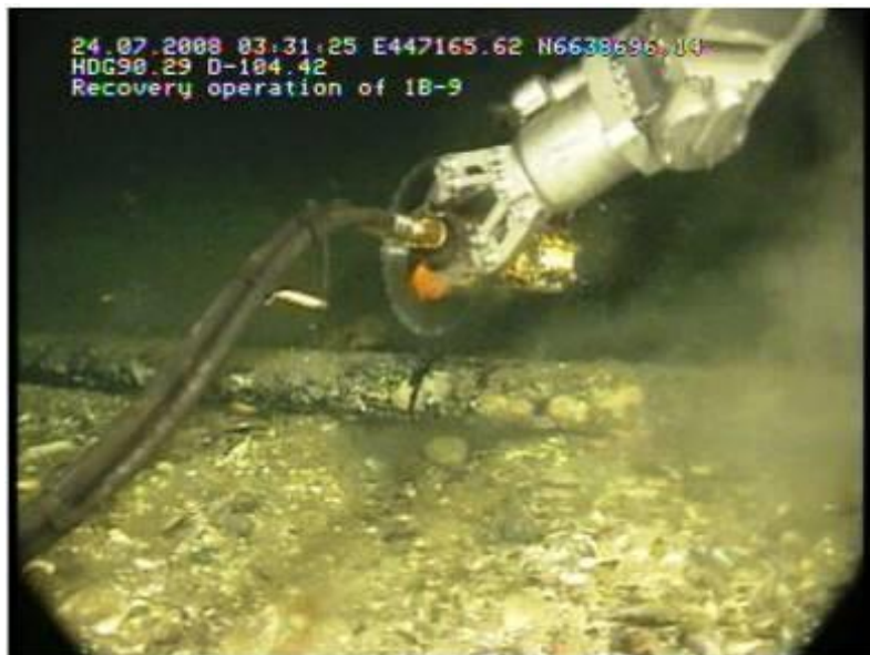
Figura 9.10 – Taglio Spool con Smerigliatrice
