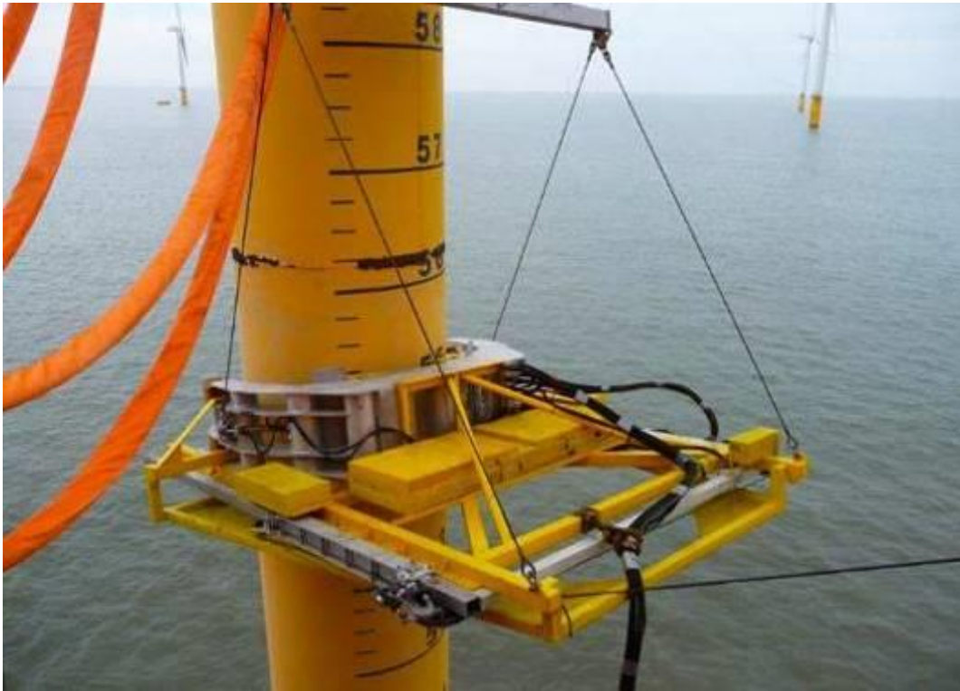
Figura 8.8 – Sistema di Taglio DWCS per Taglio a Cavo Diamantato – Tipico
