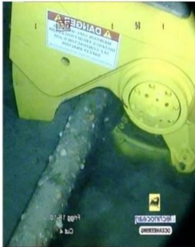
Figura 9.11 – Taglio Spool con Cesoia
