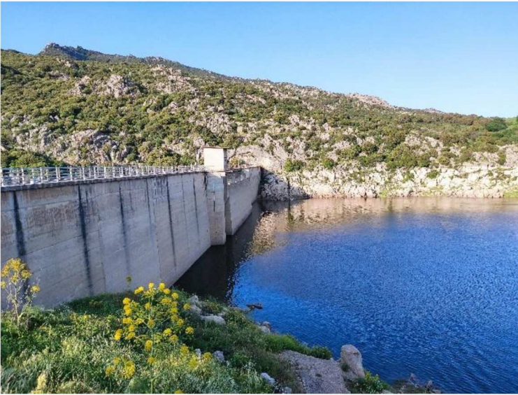
Figura 2 Vista da monte della diga
