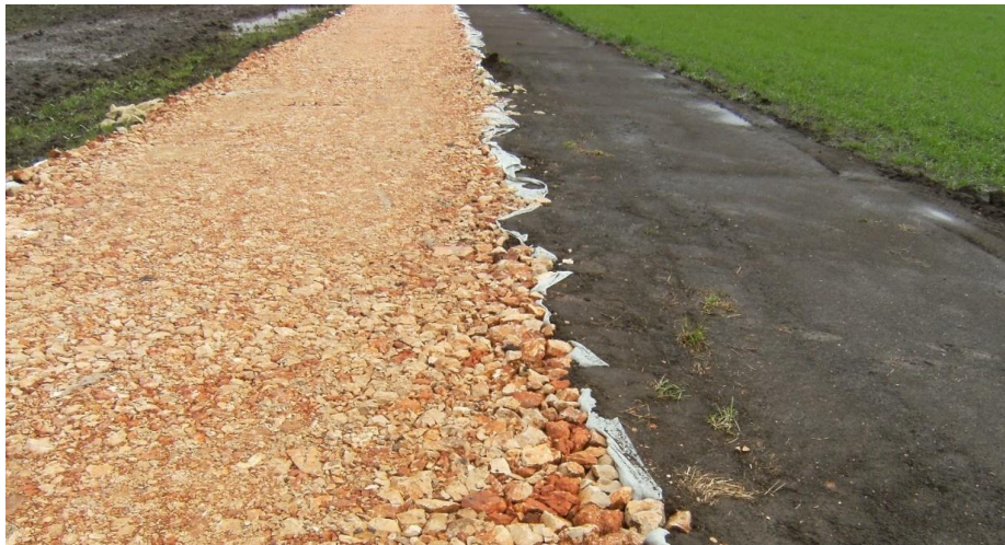
Dettaglio pacchetto stradale con geotessuto
