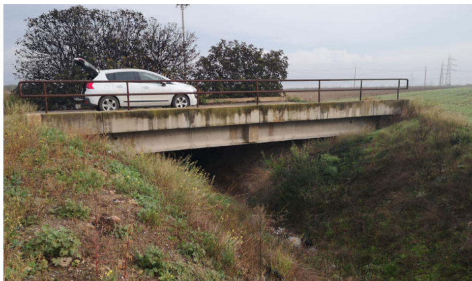
Figura 3.3: Ponte interferente con il corso d'acqua in esame
