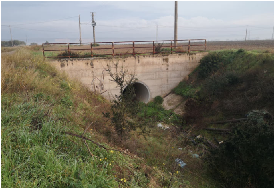
Figura 5.4: Tombino DN 2000 a monte del corso d'acqua in esame
