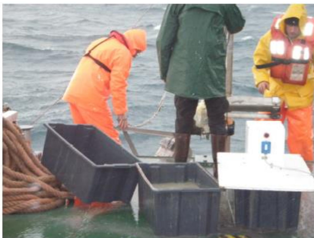
Attività di prelievo sedimenti con benna Van Veen
