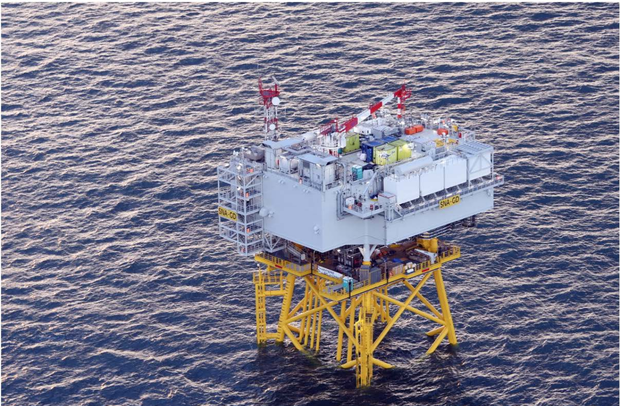
Fase operativa sottostazione offshore
