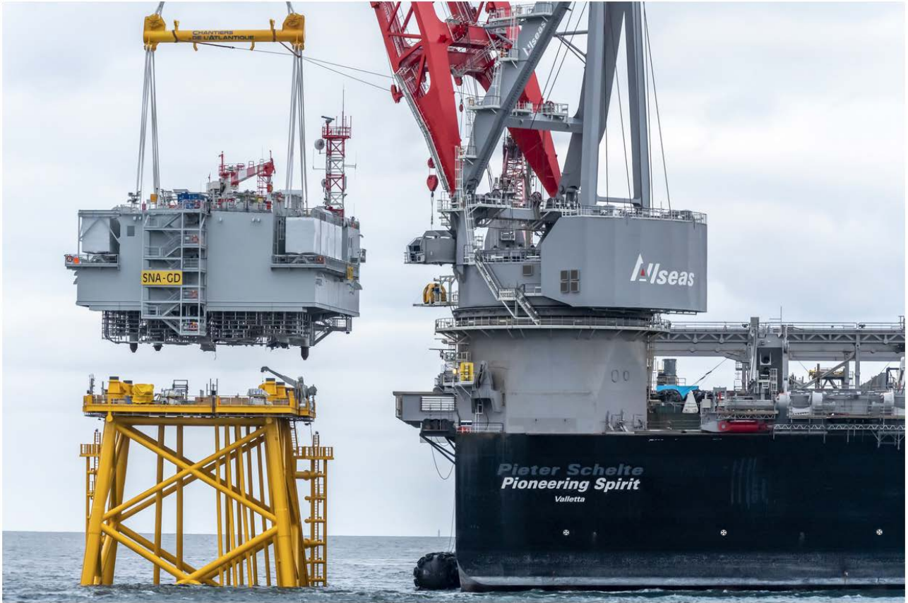
Fase di montaggio sottostazione offshore
