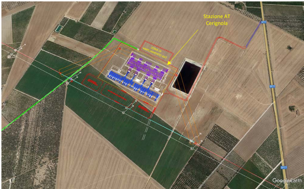
Localizzazione stazione in fase di costruzione
