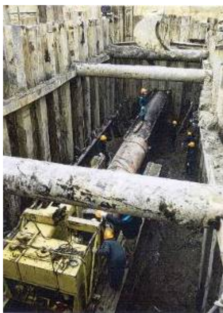
Foto 2.2-7: Trivellazione con spingitubo
