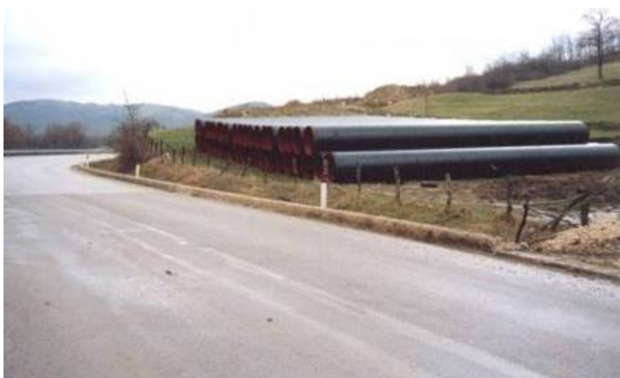
Foto 2.2-1: Piazzola di accatastamento tubazioni
