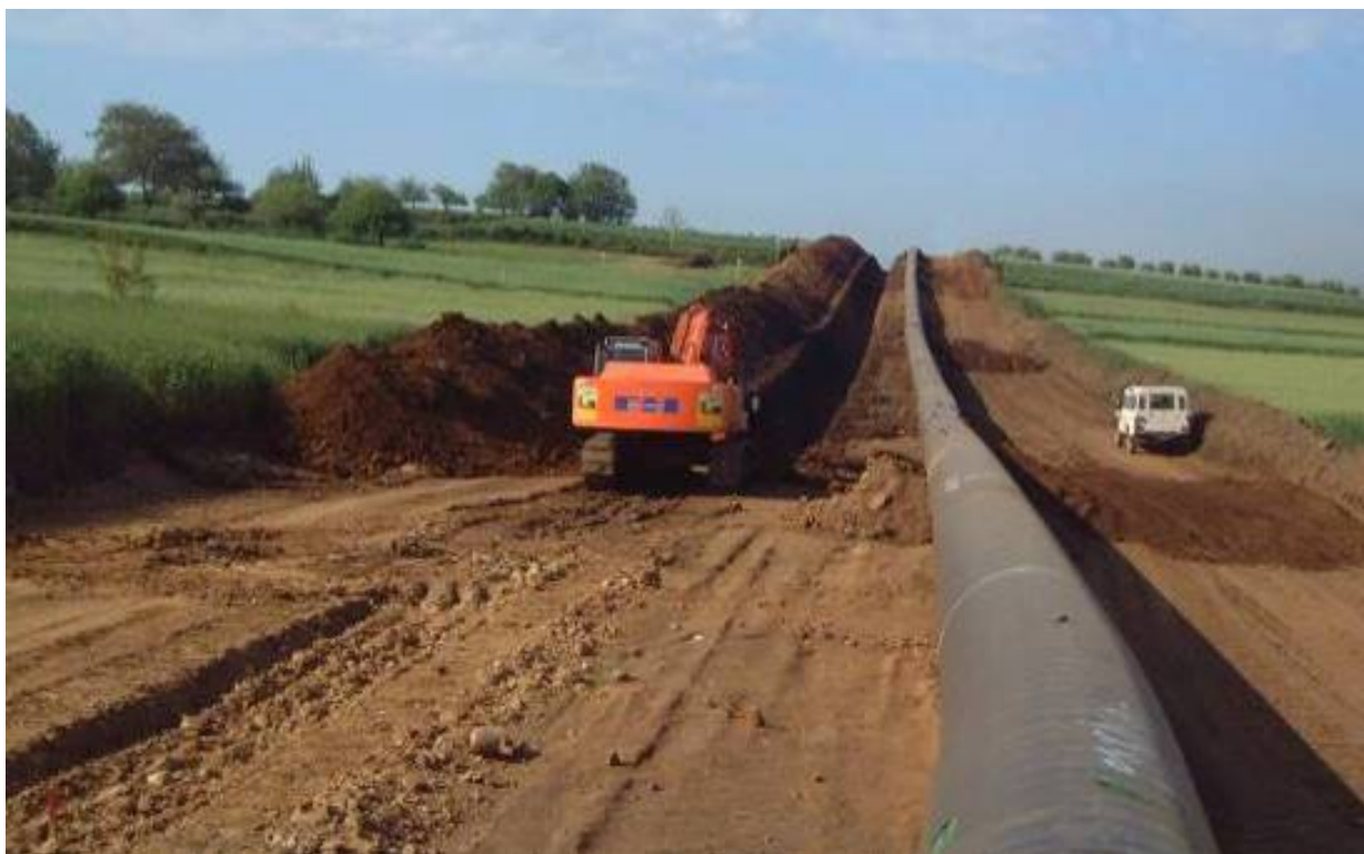
Foto 2.2-3: Scavo della trincea
