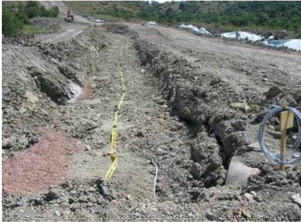
Foto 2.2-5: Rinterro della condotta
