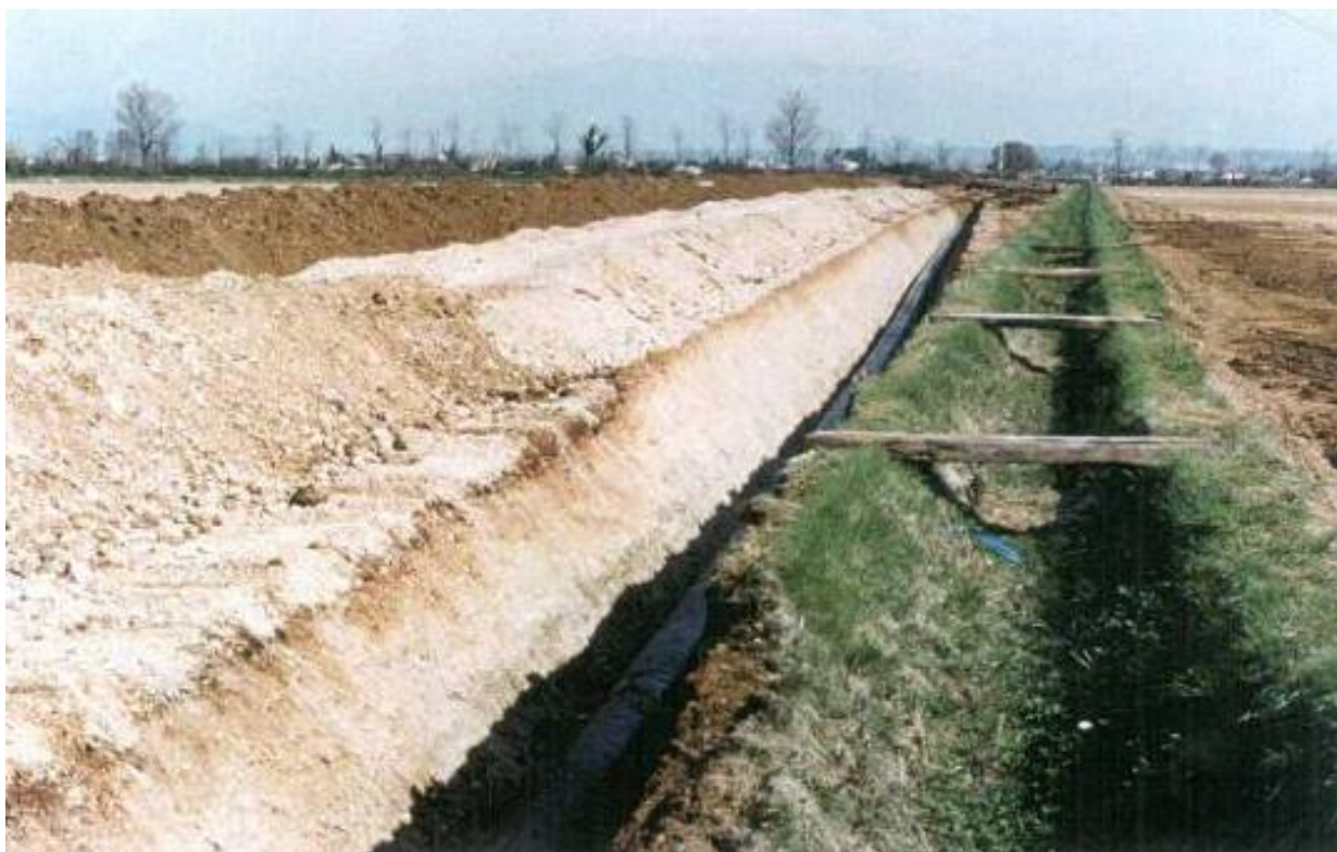
Foto 2.2-4: Tratto di condotta posata, si noti l'accantonamento dello strato humico separato dal materiale di scavo della trincea
