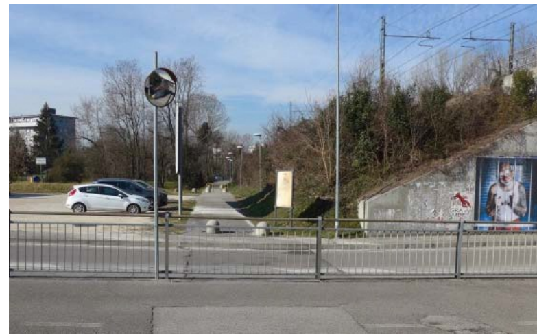
Fig. 3 - Il sottopasso di via Nuova di Corva ove è previsto lo scavalco.
