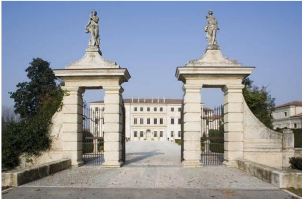
Fig. 2.97 - Villa VòPinemonte in Comune di Isola della Scala
