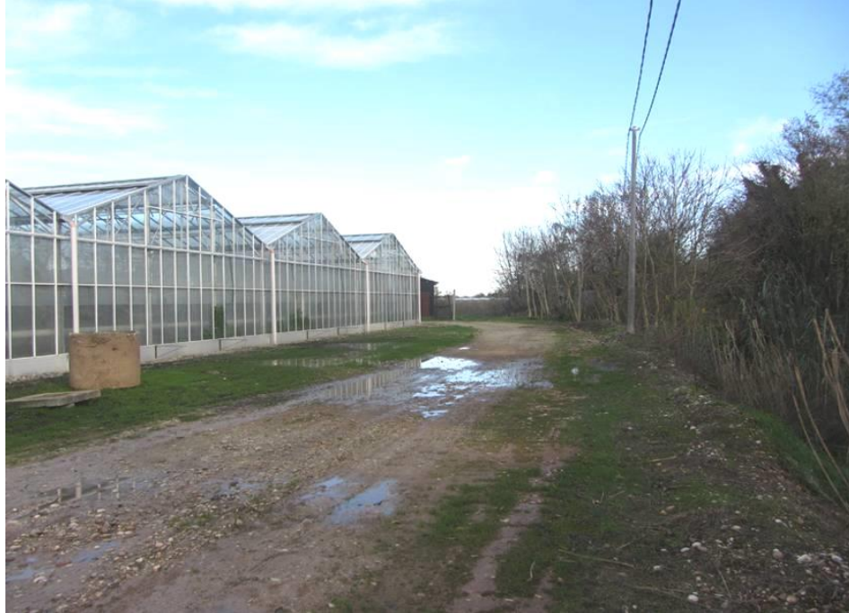
Fig. 2.81 - Capannoni di nuova costruzione in prossimità della risorgiva 115 (novembre 2013)
