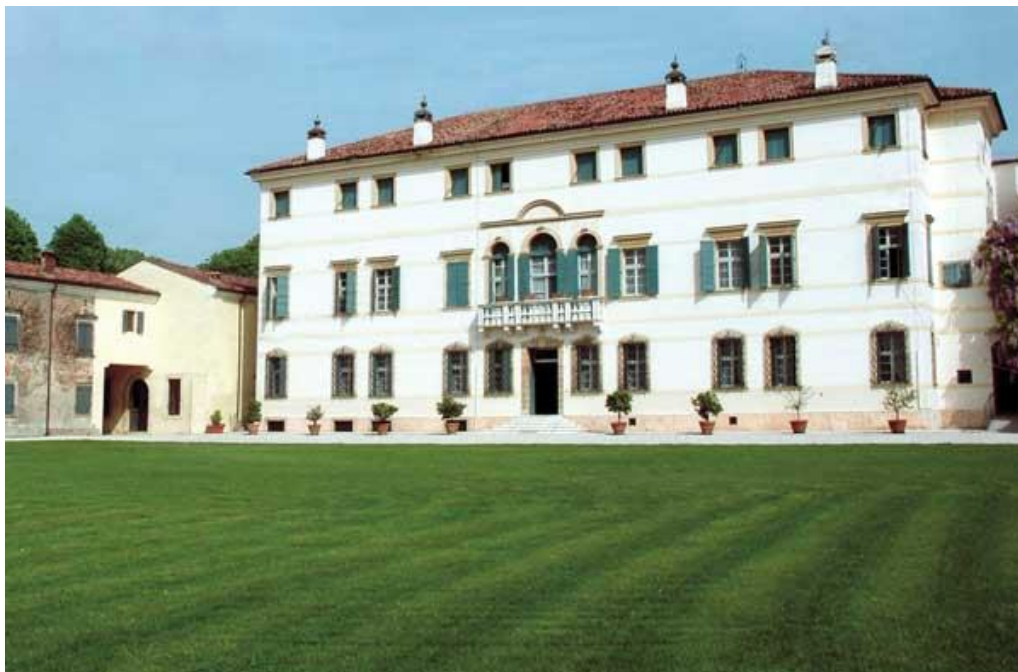
Fig. 2.98 - Villa Murari Brà. In Comune di Isola della Scala
