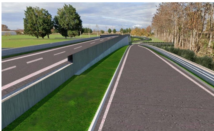
Figura 39– Mitigazione Viadotto Vigasio
