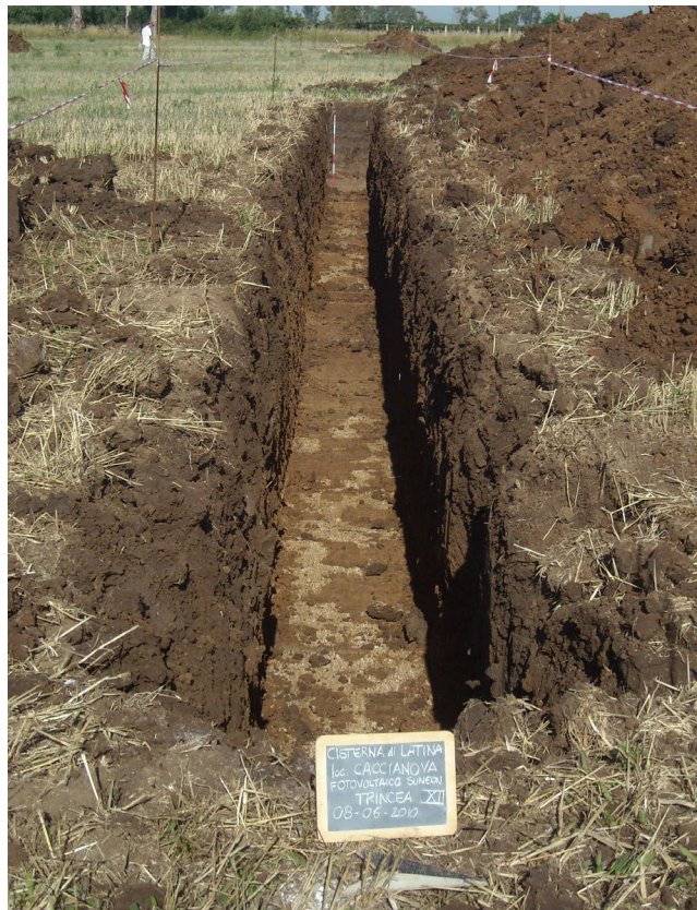
Trincea n. 12: vista generale.
