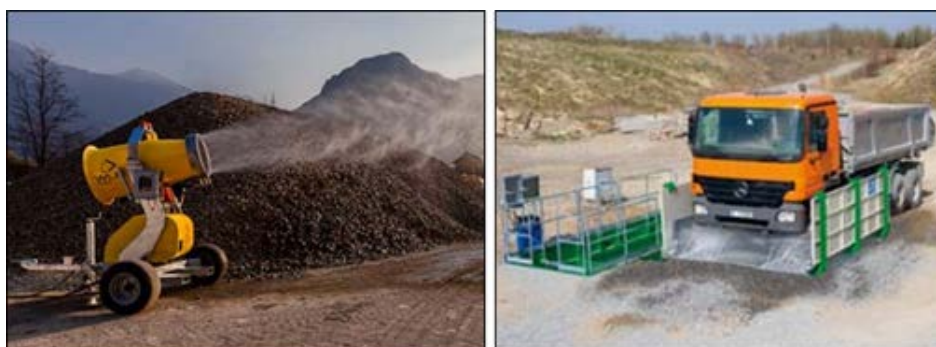
Esempio di Impianto di nebulizzazione mobile (immagine a sx) e di lavaggio ruote (immagine a dx). (Fonte: web)
