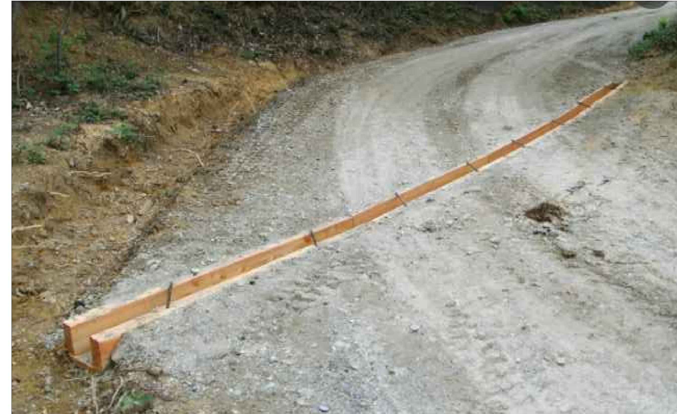
Foto particolare canaletta in legno
