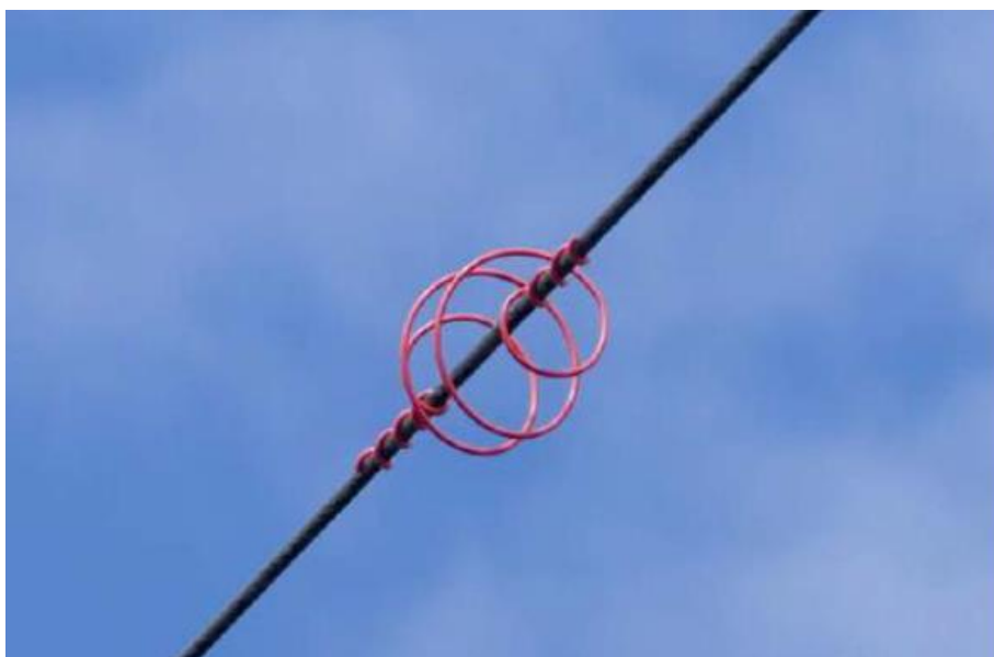
Fig. 2 – Spirale colorata in plastica per la segnalazione dei conduttori
