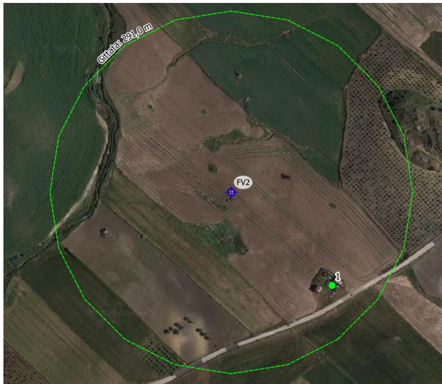
Figura 7-10 – Analisi degli effetti della rottura di un frammento di pala, aerogeneratore FV2
