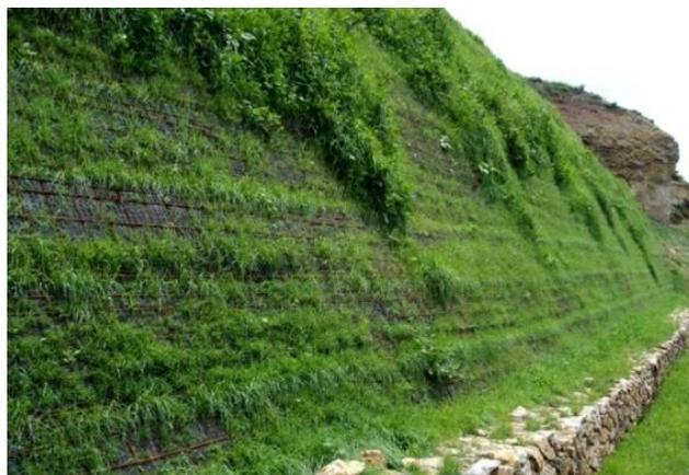
**Figura 3-11 – Esempio di applicazione di terre rinforzate**
