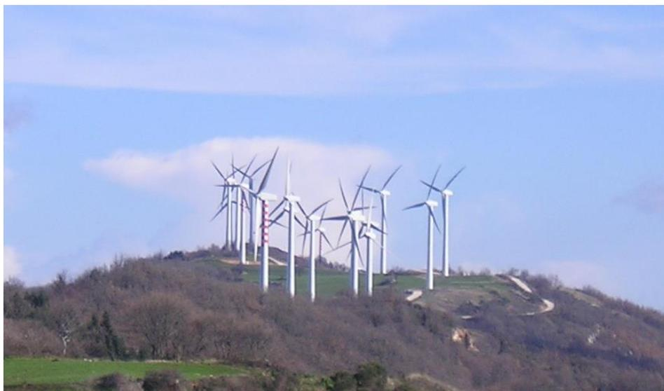
**Figura 7-1 – Esempio di effetto selva dovuto all'utilizzo di generatori di media taglia (Vestas V47-660 kW)**
