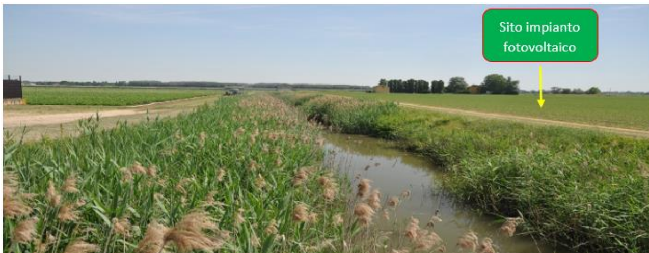
Canale di raccolta delle acque
