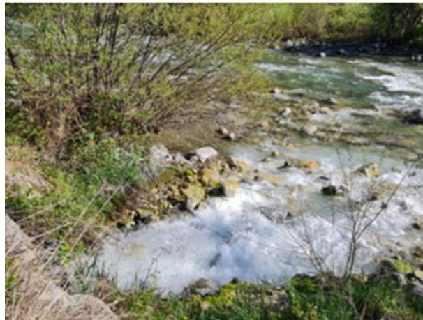
Scarico acque del depuratore nell'Isarco
