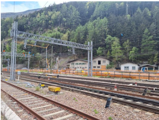
Blick in den Südwestbereich / Vista area sud ovest
