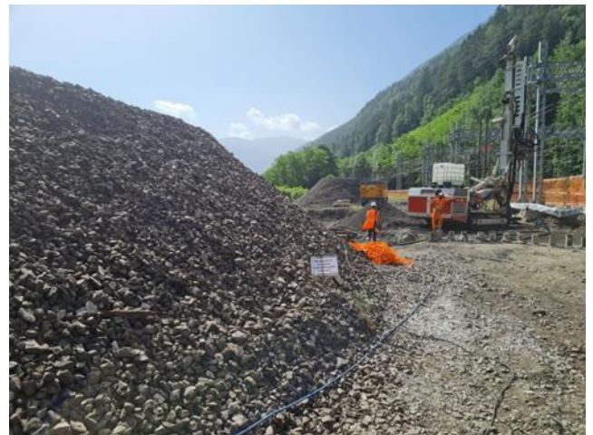
Südlicher Bereich, westlicher Sektor: Ortsbetonpalisade Area sud zona ovest: palizzata gettata in opera
