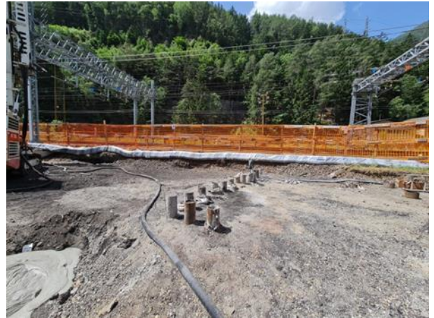
Südlicher Bereich, westlicher Sektor: Ortsbetonpalisade Area sud zona ovest: palizzata gettata in opera
