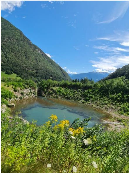
Cassa di espansione sul rio Riol realizzata a monte degli abitati situati nell'omonima via
