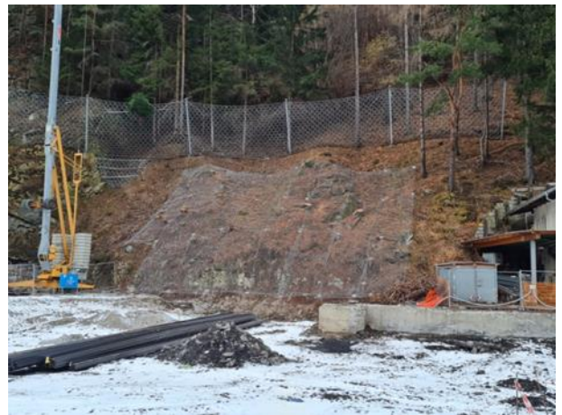
Steinschlagschutznetze zum Schutz der darunterliegenden Wohnhäuser
