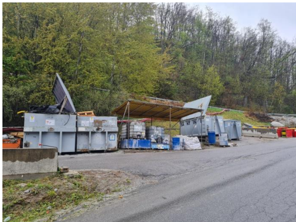
Baustelle Unterplattner Cantieri di Unterplattner
