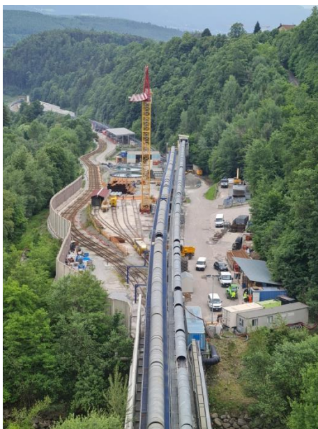
Scorcio area di cantiere
