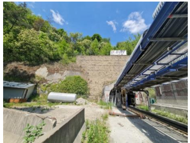
Area nord del cantiere
