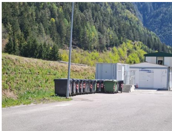
Baustelle Muls 2 / Cantiere di Mules 2
