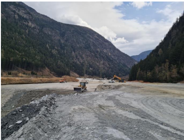
Fase di riempimento area di cava
