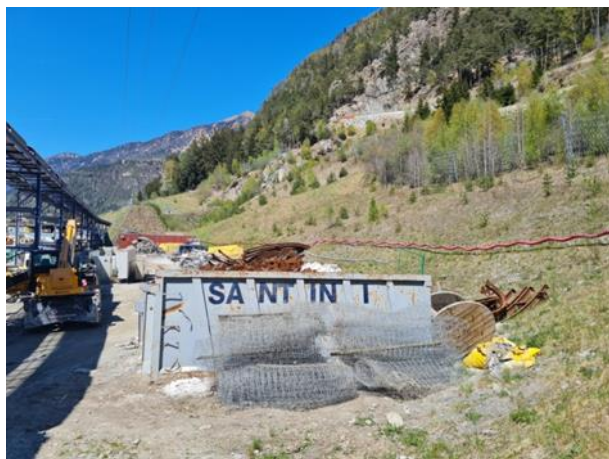
Baustelle Muls 1 / Cantiere di Mules 1
