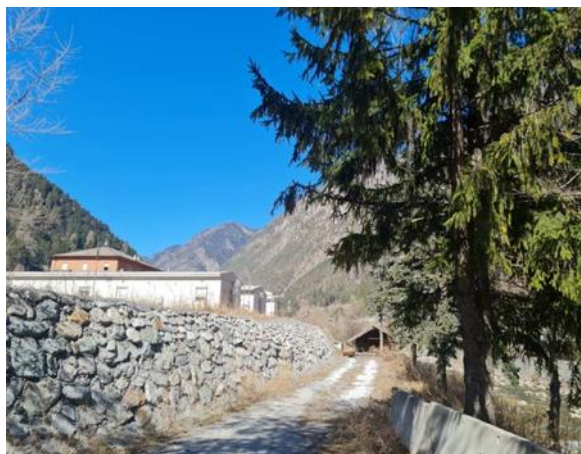
Uferzone Fascia ripariale
