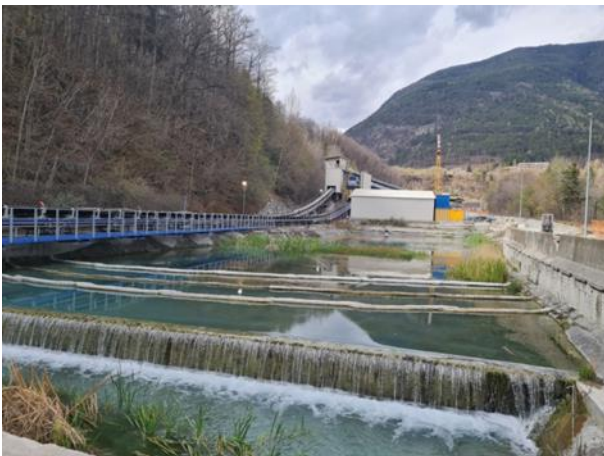
Absetzbecken / Vasche di decantazione
