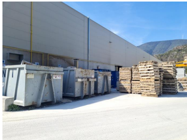
Baustelle Hinterrigger Cantieri di Hinterrigger
