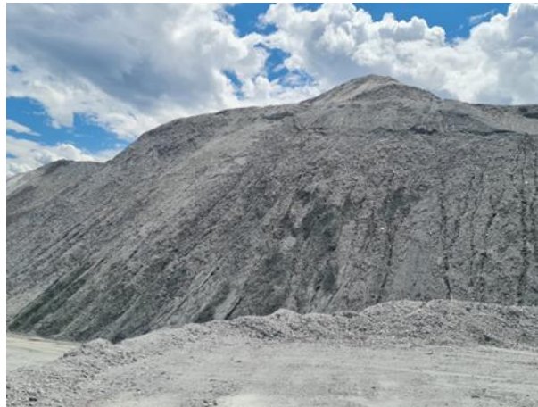
Erosionen an den südlichen Böschungen Processi erosivi sulle scarpate meridionali
