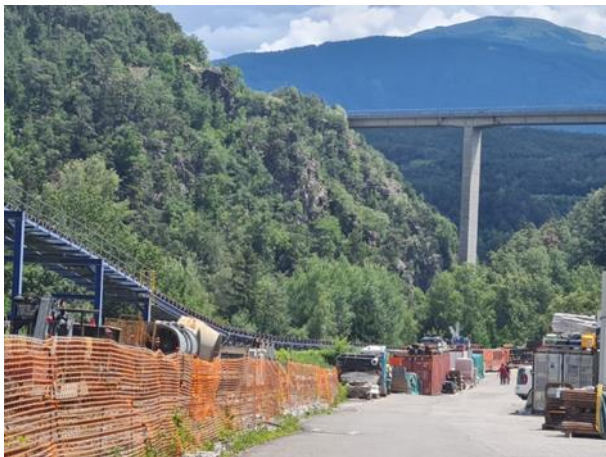
Area sud del cantiere
