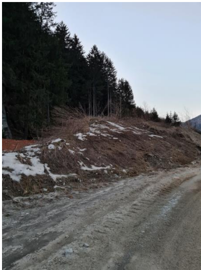
Cumulo di terreno vegetale in pausa invernale
