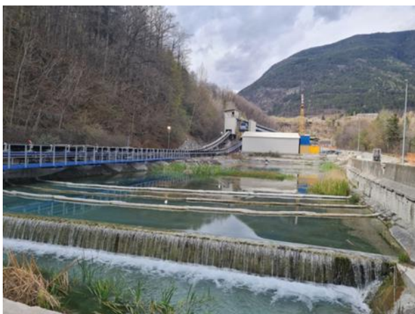
Wasseraufbereitungsanlage Impianto acque
