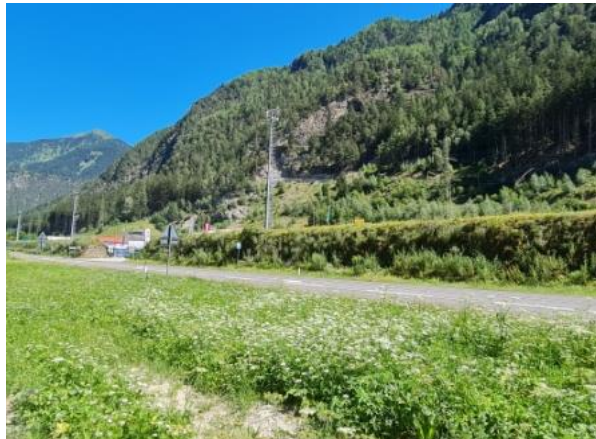
Vista del cantiere dalla strada statale
