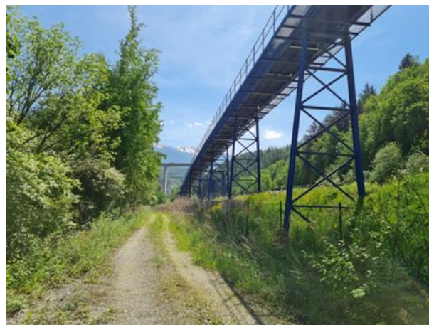
Uferzone Fascia ripariale
