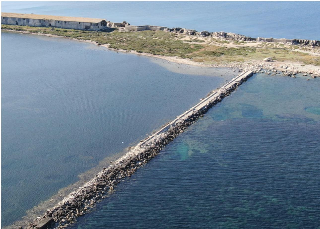
*Figura 13 – Lo stato di conservazione del pennello – Vista da drone, 2022*
