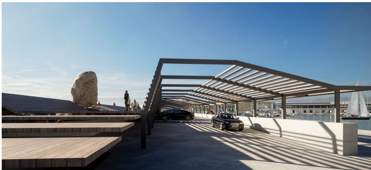
Vista della passeggiata di Via Catulo Lutazio – Percorso pedonale, parcheggio, pista ciclabile
