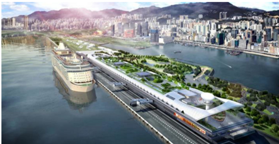
Terminale ad uso misto (Porto di Hong-Kong, terminale di Kai-Tak, 2015)
