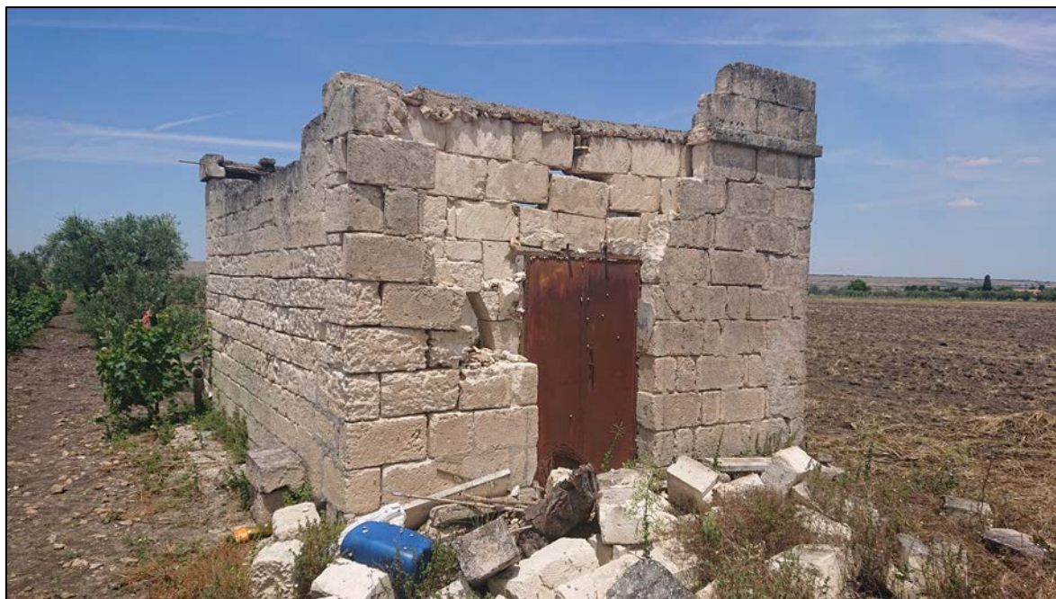
Casolare monocellulare in tufo parzialmente crollata
