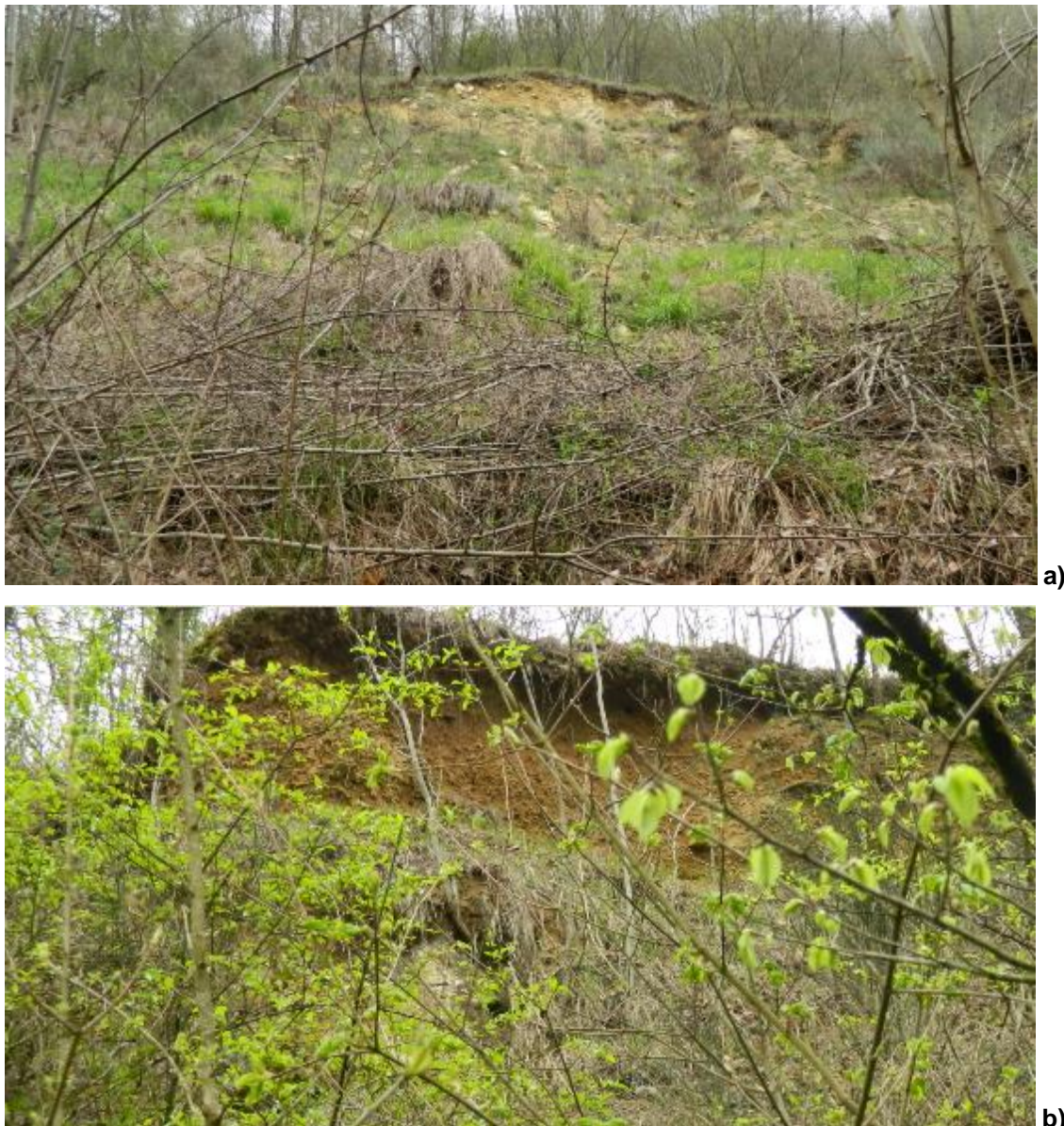
Figura 12-1 – Versante occidentale del colle del Canniccio, lungo la strada del Mulino di Bruschetto: a) dissesto recente che ha ostruito la strada; b) coltre detritica di disfacimento della Formazione di Monte Morello messa a nudo da un episodio franoso.
