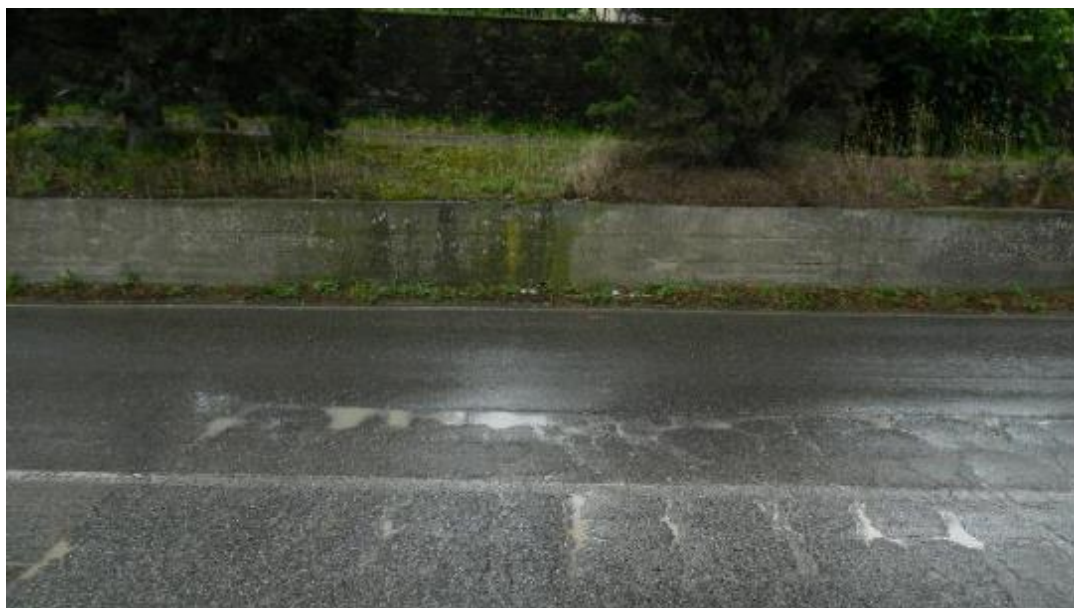
Figura 12-4 – Lesioni su asfalto e muretto lungo la strada S.R.69 in località Le Coste
