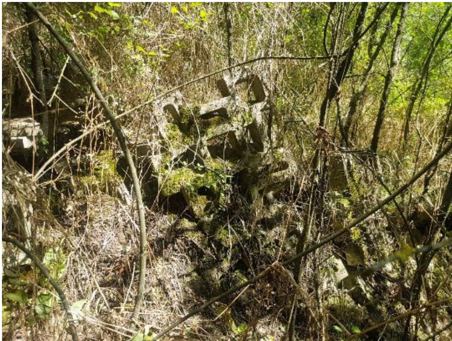
Figure 12-6a,b – Geogriglie disarticolate (versante prospiciente l'area di parcheggio Arno Ovest)
