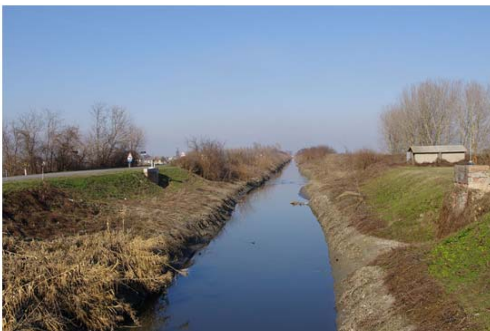
Figura 8.2.k – Canale Savena Abbandonato presso località Casoni
