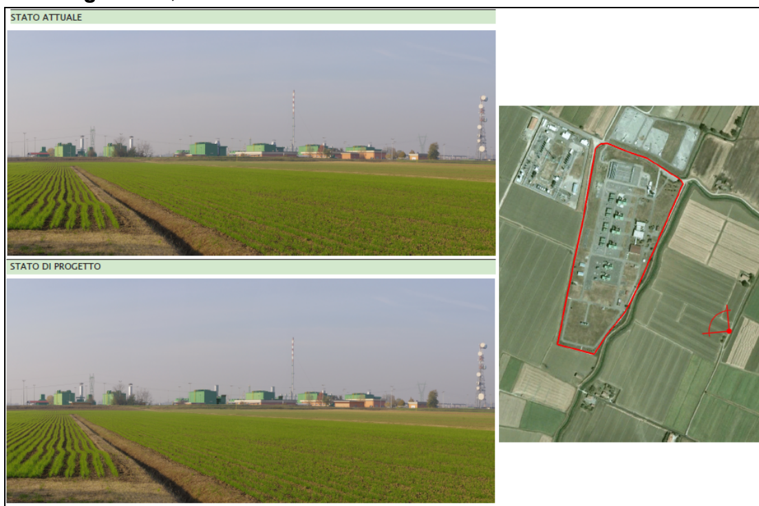
Figura 8.1.a – Intervento di adeguamento dei turbocompressori TC-3 e TC-4
