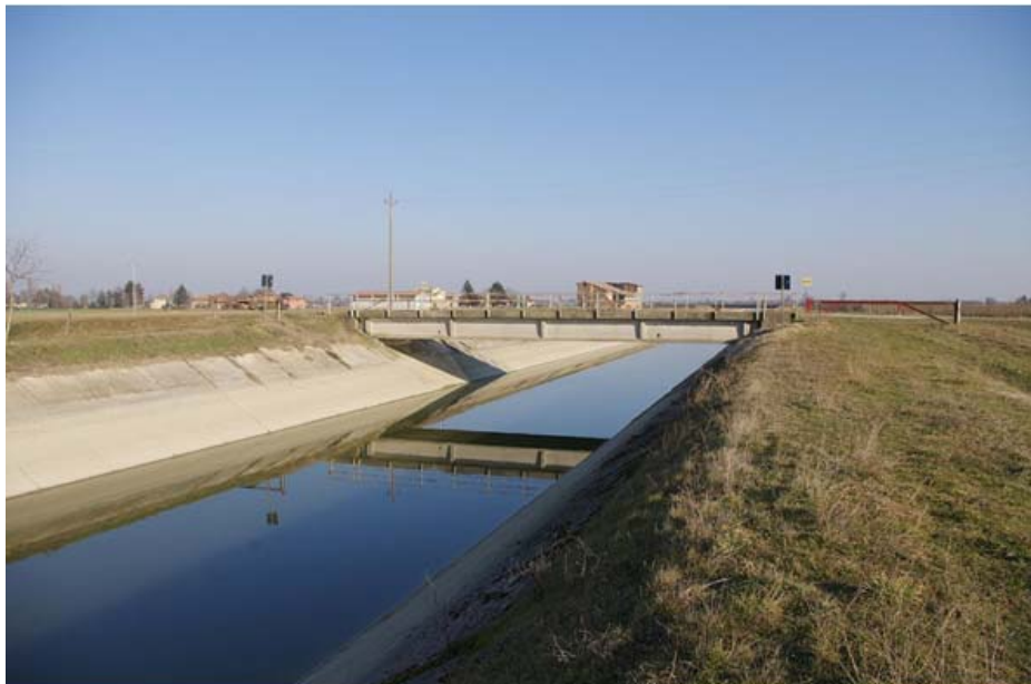
Figura 8.2.b – Canale Emiliano Romagnolo presso località Cazzano
