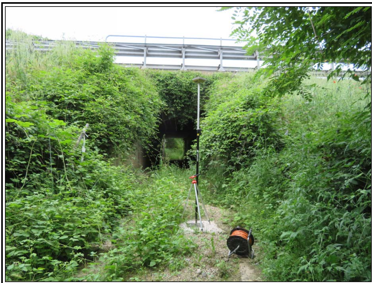
Figura 1. FOTO RILIEVO TOPOGRAFICO
