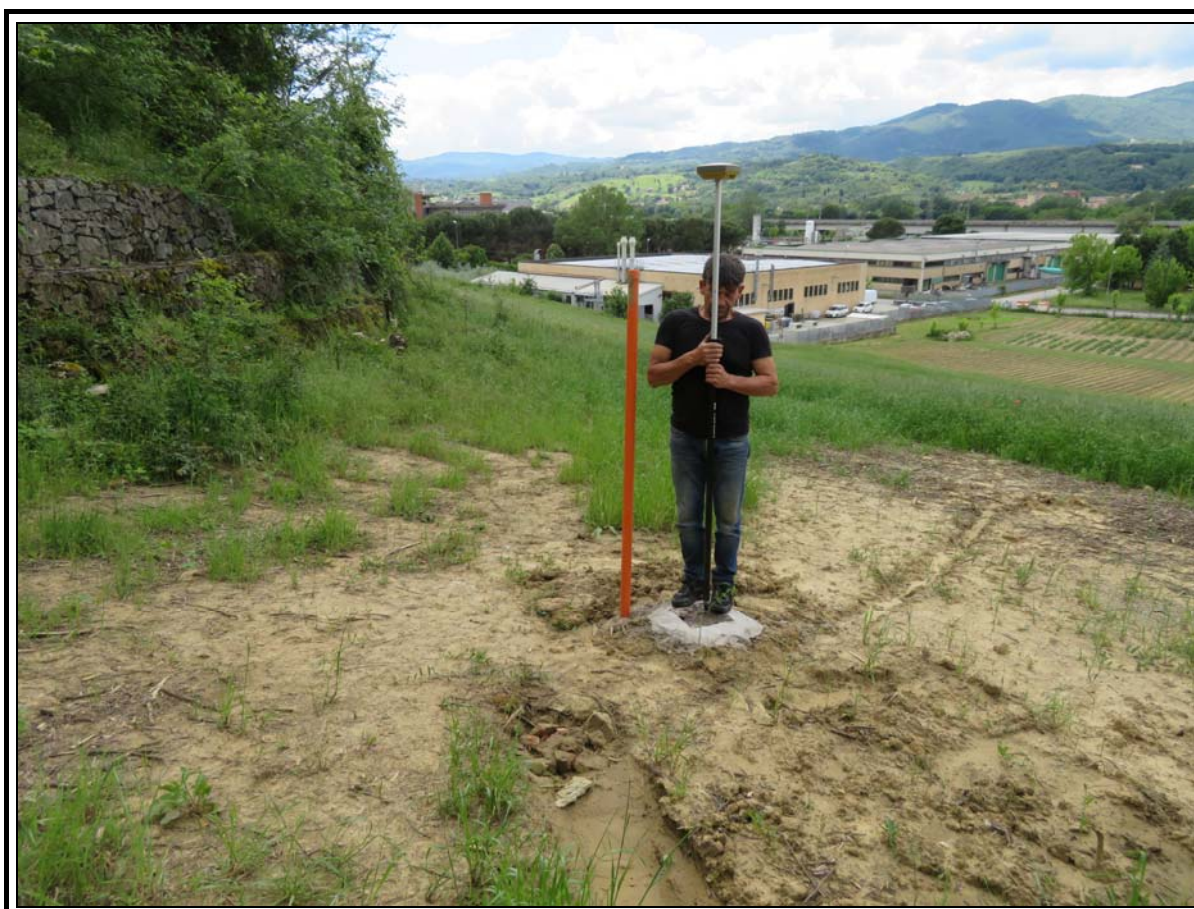
Figura 1. FOTO RILIEVO TOPOGRAFICO
