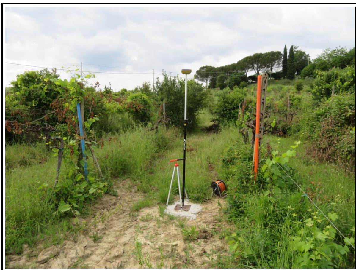
Figura 1. FOTO RILIEVO TOPOGRAFICO
