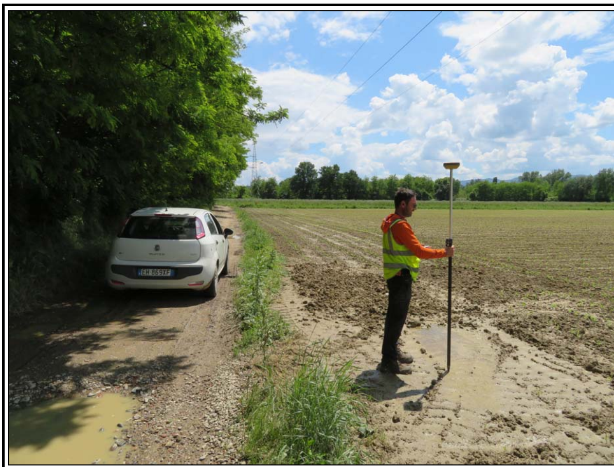
Figura 1. FOTO RILIEVO TOPOGRAFICO
