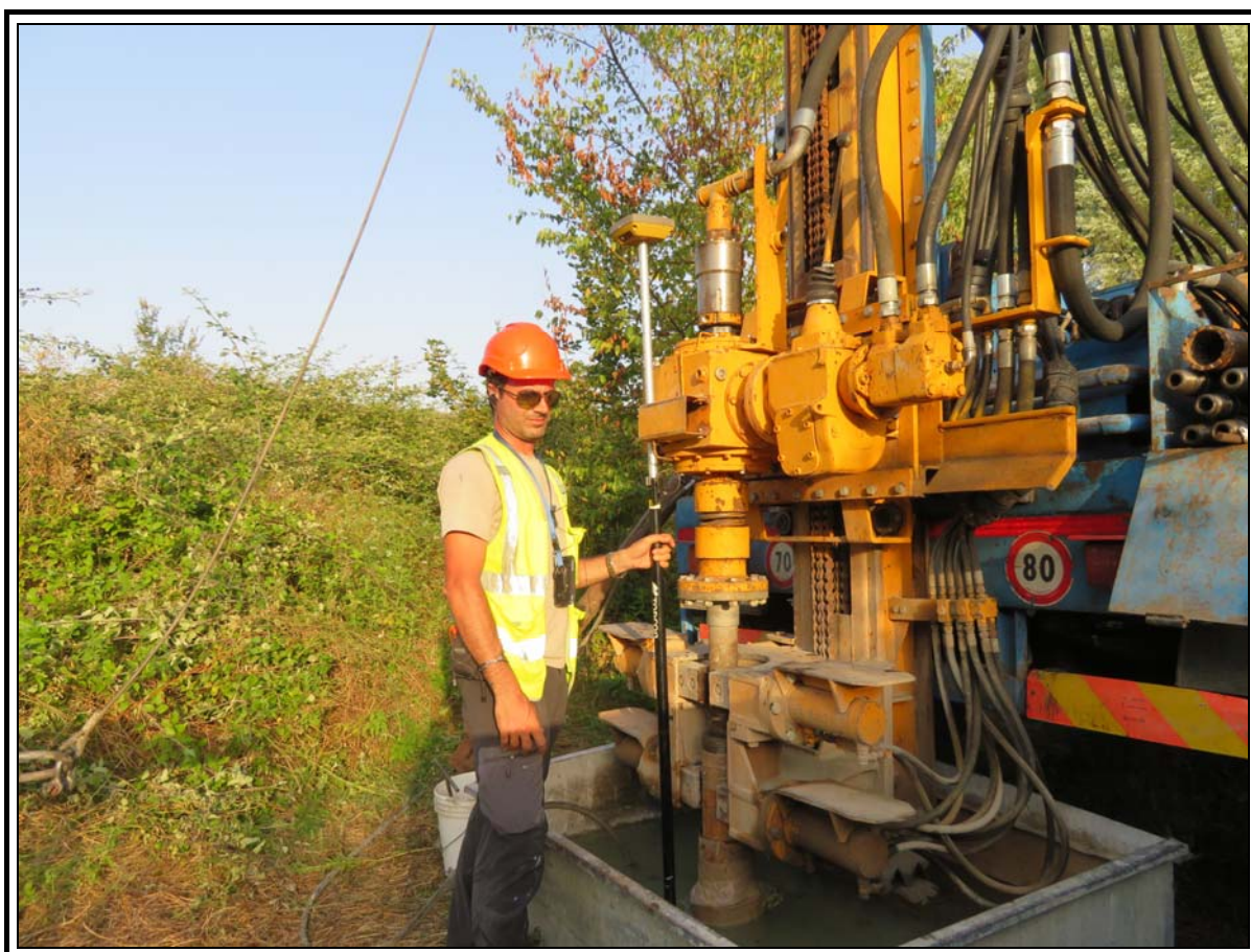
Figura 1. FOTO RILIEVO TOPOGRAFICO
