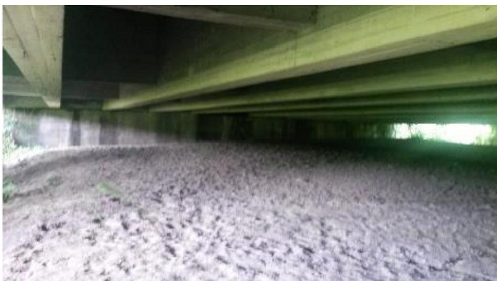
**Figura 12-8** – Deposito alluvionale attuale dell'Arno sedimentato al di sotto dell'impalcato autostradale (foto del 12/06/2018).
