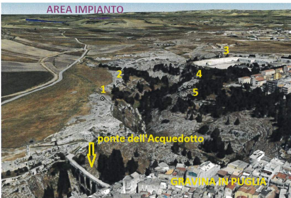
Fig. 5 Punti di scatto rispetto al contesto dell'abitato di Gravina.
