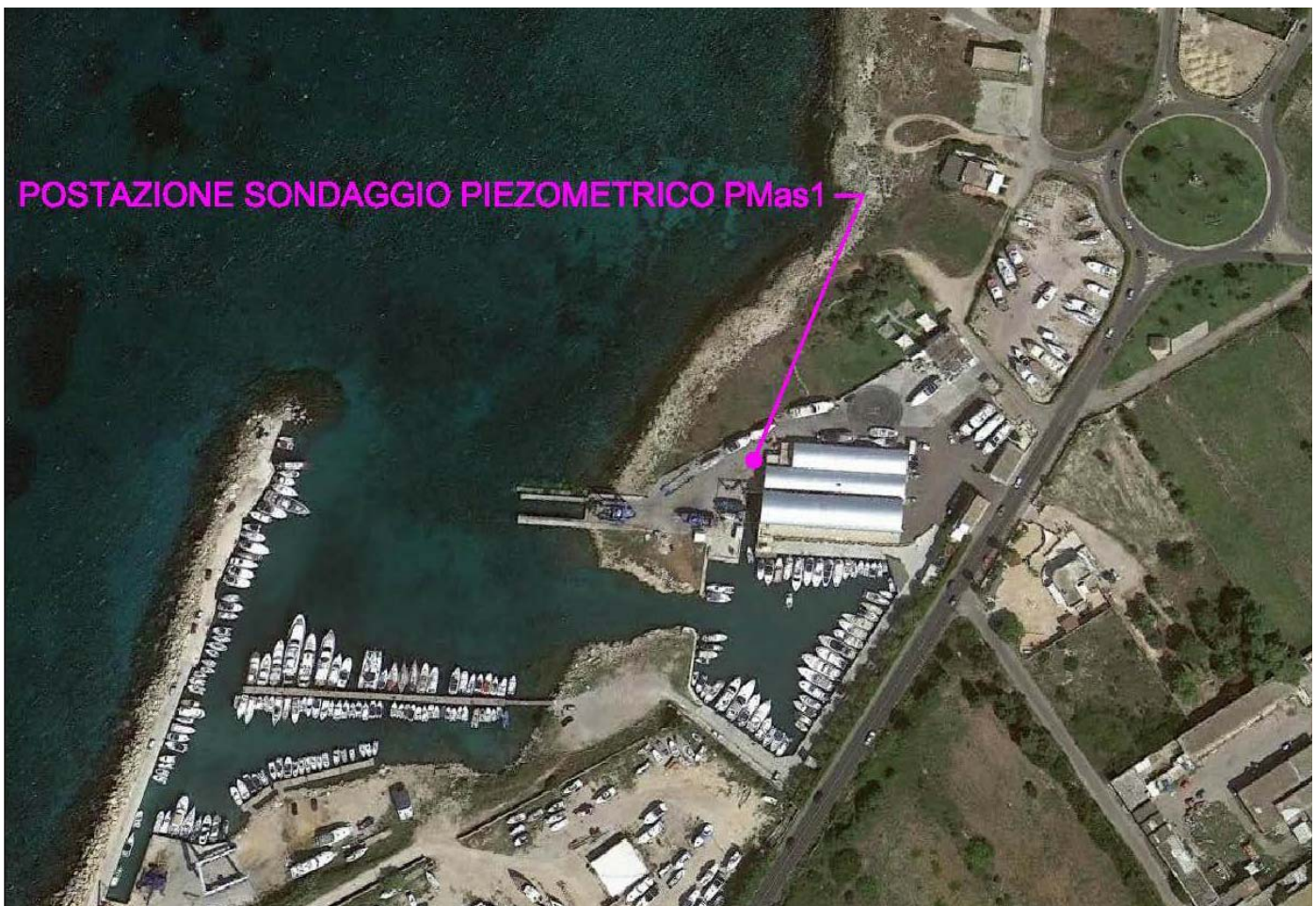
Postazione pozzo PMas1
