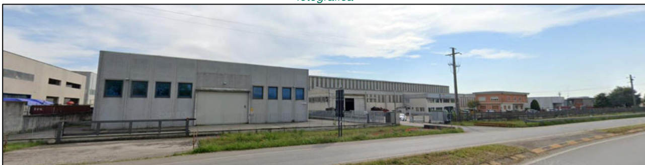
Fig.3.1.J – Area industriale di Calcinato affacciate sulla viabilità provinciale (R08) – documentazione fotografica
