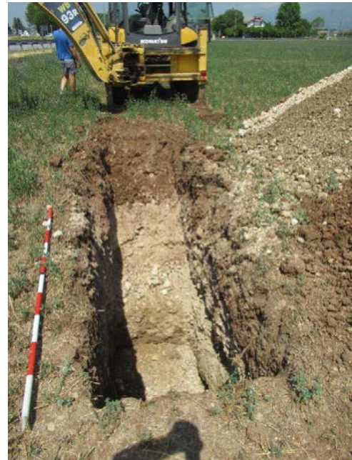
Fig. 52. Sondaggio 3 visto da est
