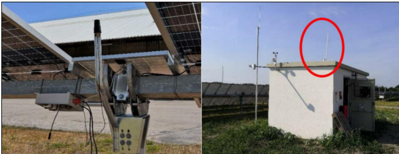
Figura 5.10: Esempio di collegamento - L'antenna TP sul tracker (a sinistra) e l'antenna del RP nella parte superiore della stazione di trasformazione (a destra).
