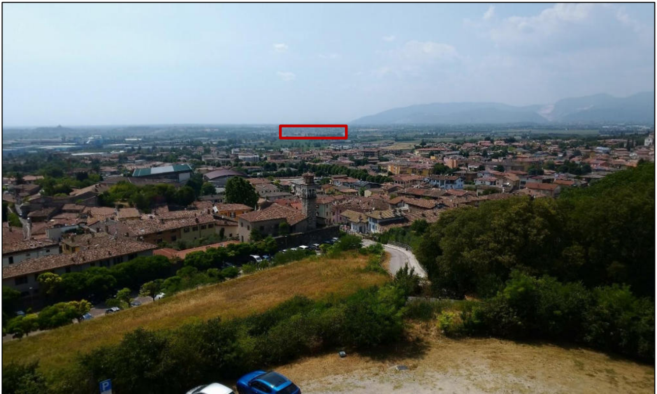
Figura 6.8: vista 4 dell'area in cui è prevista la realizzazione del campo agrivoltaico (bordata con segno rosso) guardando verso ovest dal castello di Lonato che di fatto costituisce il punto più alto e più distante da cui è osservabile l'area di intervento (visuale statica). Foto ante operam.
