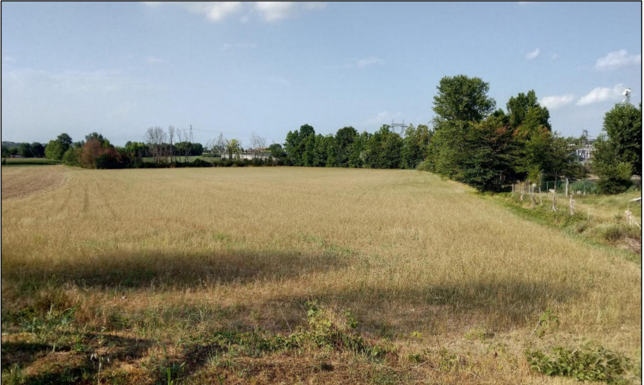
Figura 6.15: vista 6 post operam. La presenza della nuova sottostazione è parzialmente occultata da quella esistente e dalla presenza di vegetazione a cui si aggiungono le opere di mitigazione che mascherano ulteriormente l'opera grazie alla creazione di una fascia arbustiva larga 6 m e alta 1-2m.
