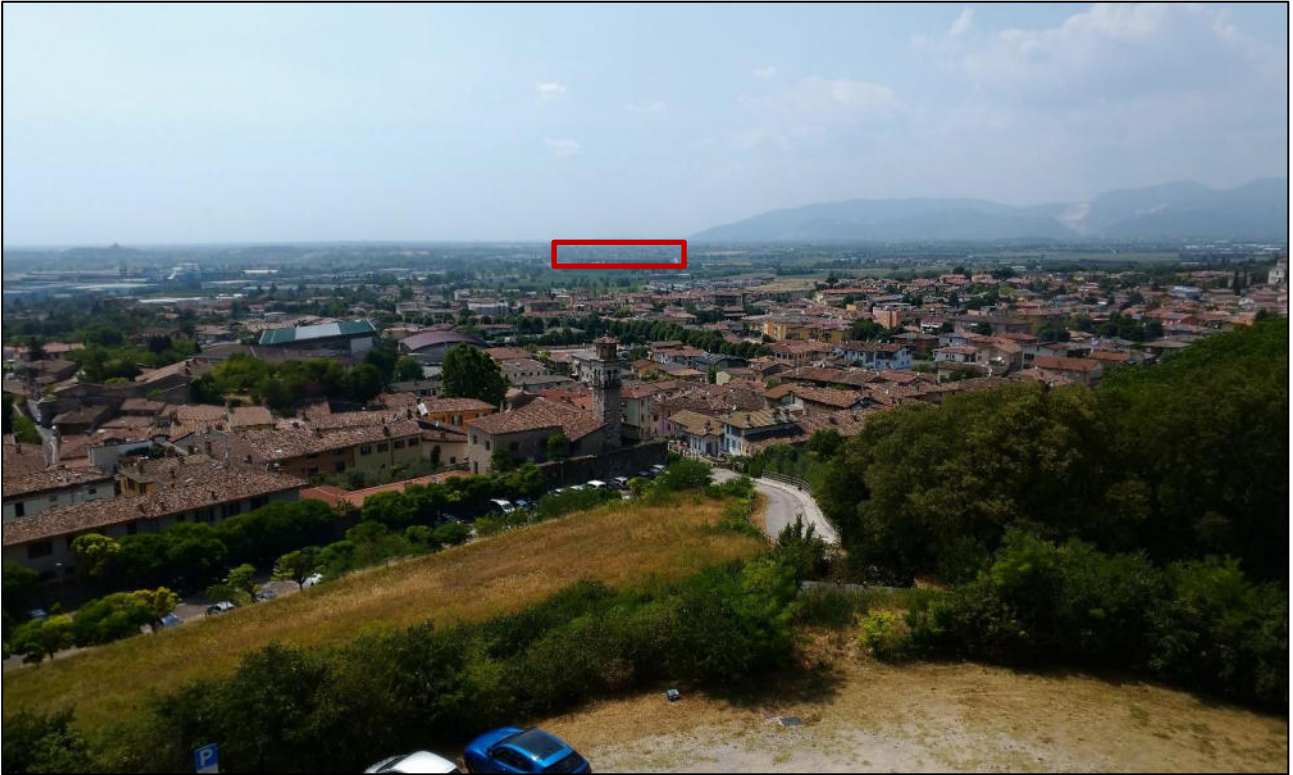
Figura 6.9: vista 4 post operam. Le modificazioni dell'area di intervento risultano appena visibili e si manifestano come un cambiamento del colore rispetto alla trama agricola.
