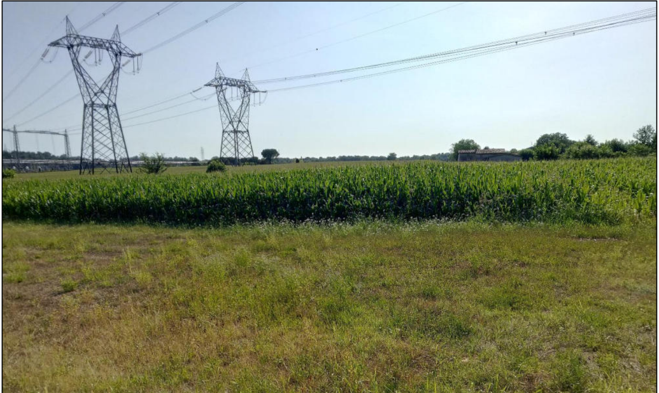
Figura 6.12: vista 5 ante operam. L'area d'intervento è posta dietro la coltivazione di mais in primo piano, guardando verso ovest dalla SS n 587 del Benaco (punto di osservazione dinamico). Questo è il punto posto sulla strada da cui l'opera risulterà meglio visibile ma, come si può notare, il cono visivo risulta già impattato dalla presenza dei sostegni e della SE sulla sinistra.
