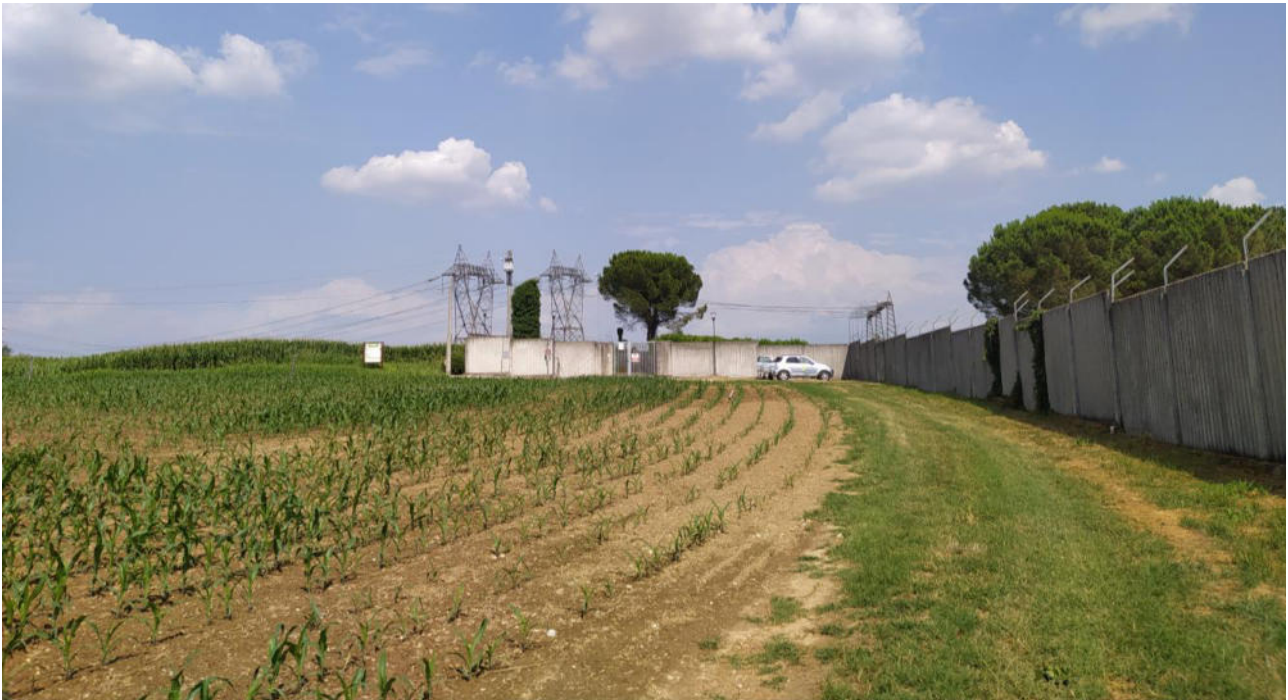
Figura 5: vista dell'area ove sorgerà la sottostazione elettrica, nelle immediate vicinanze della stazione elettrica Terna spa.
