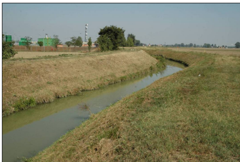
Figura 5.6.c – Scolo Zena nei pressi dell’impianto di compressione di Minerbio
