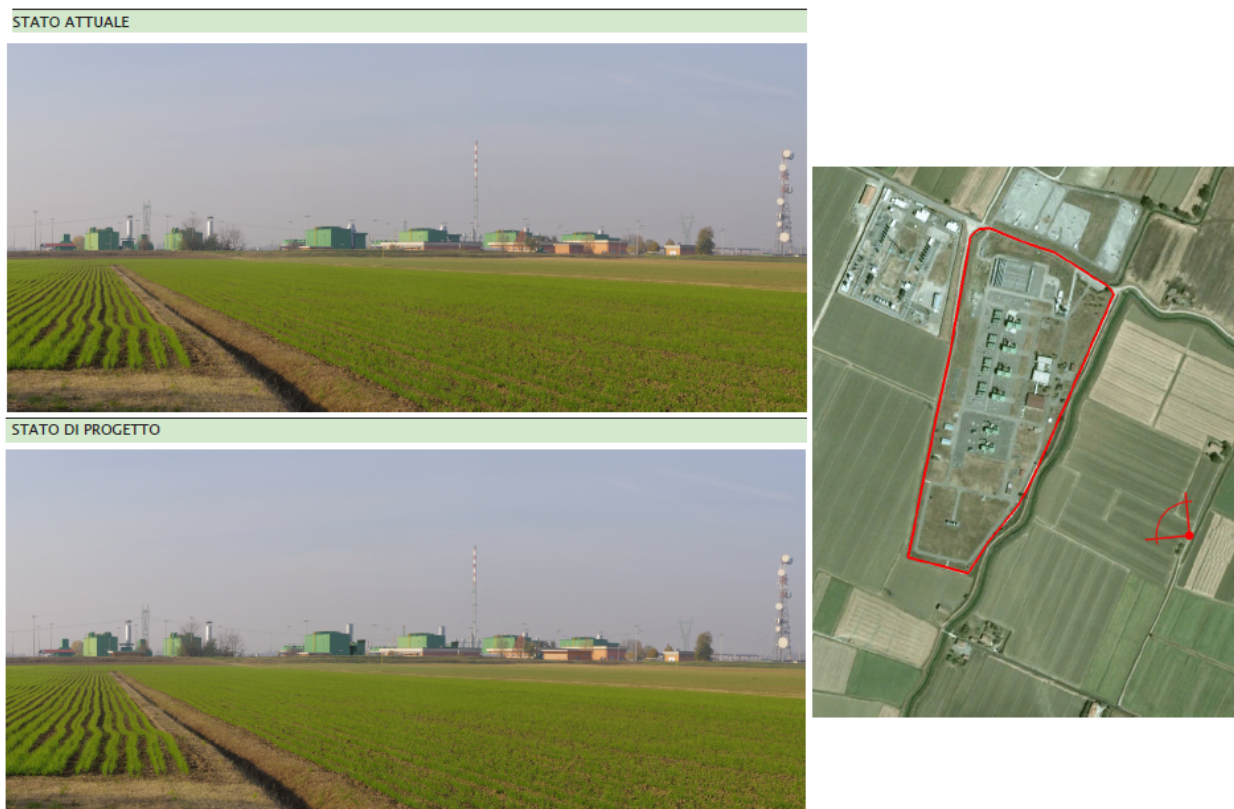
Figura 5.8.a – Intervento di adeguamento dei turbocompressori TC-3 e TC-4
