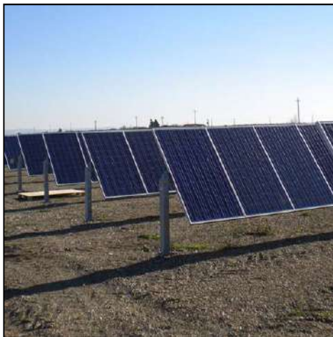
Figura n.7 – Rappresentazione della struttura di supporto vista frontale
